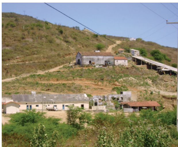
Figura 4.6 - Vista panorâmica da região da mina de scheelita de Bodó (Bodó).
