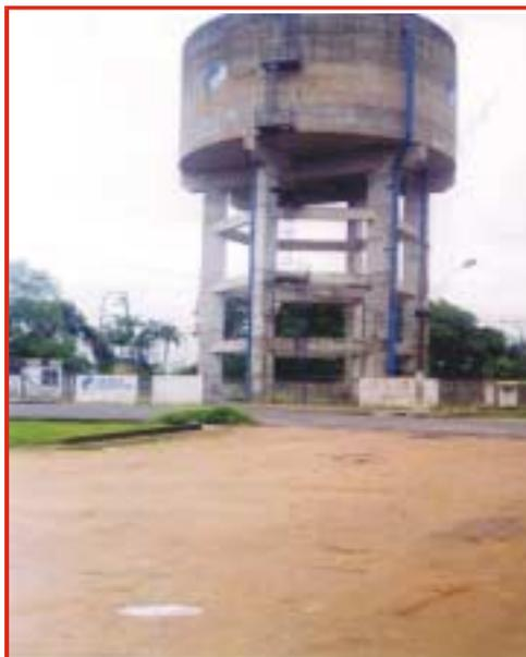
Foto 07. Elevatória de água tratada de 2.000 m<sup>3</sup>, utilizada na compensação da pressão no horário de maior demanda
