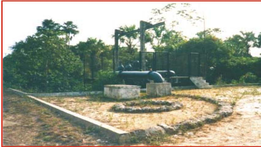
Foto 05. Conjunto de bombas operando na captação da água bruta do Rio Chumucuí.
