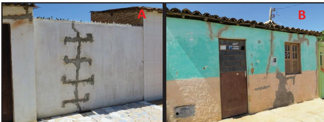
Figura 5.9: Trincas nos muros das residências (A e B). Conjunto de casas populares. (Fotos do autor)
