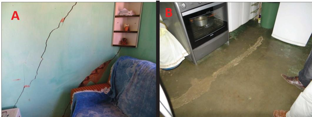
Figura 5.44: (A) Trincas parede. (B) Trincas piso. (Fotos do autor)
