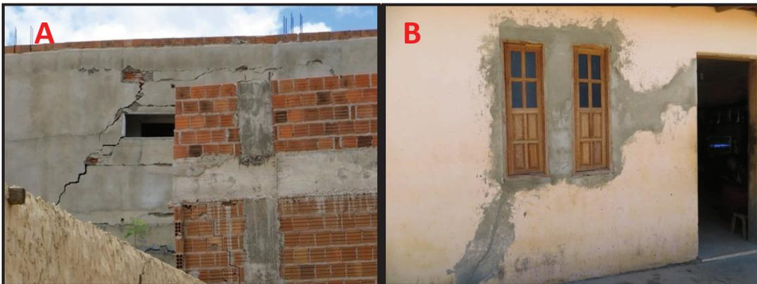
Figura 5.50: Construções danificadas construídas sobre dolina. Centro (A); Casas Populares(B). (Fotos do autor)
