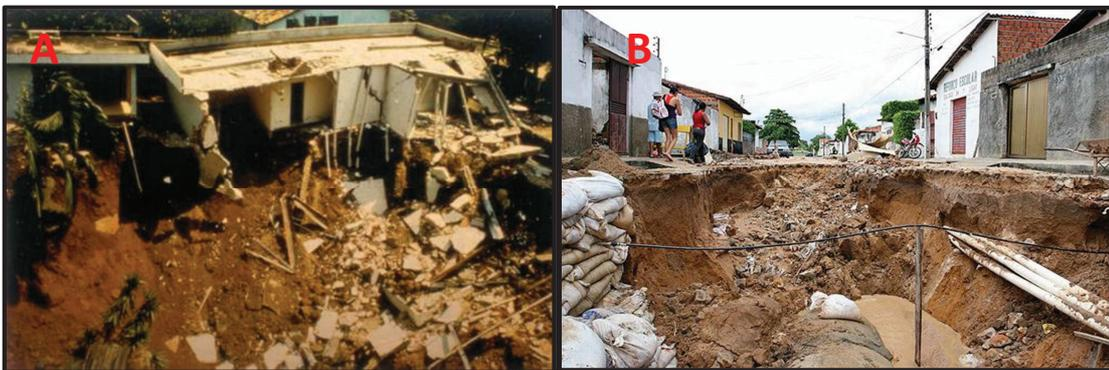
Figura 2.10: (A) Colapso de solo em Cajamar - SP (1986). Disponível em: [www.rc.unesp.br/igce/aplicada/ead/interacao/inter12.html](http://www.rc.unesp.br/igce/aplicada/ead/interacao/inter12.html). Acesso em 21/10/2014. (B) Afundamento de rua em Teresina - PI. Disponível em: [www.portalaz.com.br/noticia/Grande\\_dirceu/136239](http://www.portalaz.com.br/noticia/Grande_dirceu/136239). Acesso em 21/10/2014.
