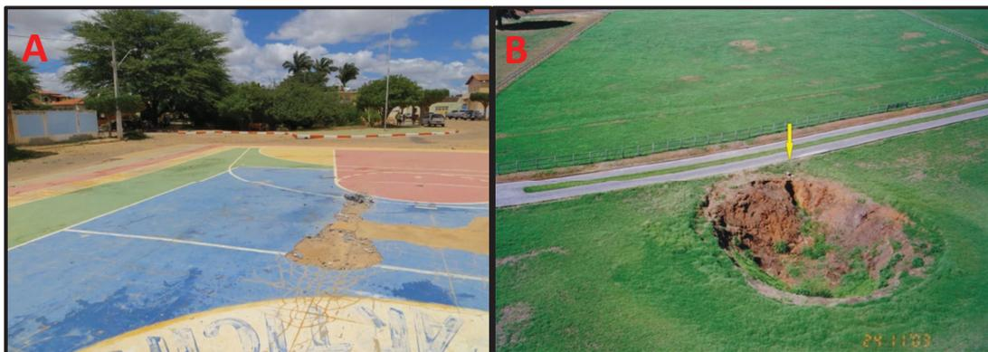
Figura 2.11: (A) Afundamentos em Lapão (Foto do autor). Rachaduras na Quadra de Esportes. UTM: 190765 E / 8740153 S. (B) Figura 2.14: Dolina circular em Matozinhos - MG. Fonte: Resende Costa (2013).
