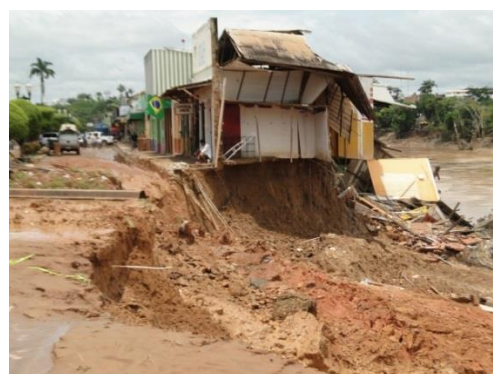
Figura 29. Imóveis destruídos pelas águas. Rua Rolando Moreira.
