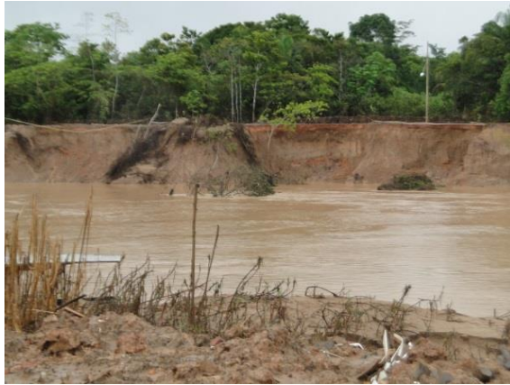
Figura 40. Terras caídas pela margem esquerda do rio Acre, defronte a cidade de Xapuri.
