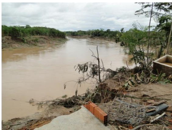
Figura 7. Rio Acre, impactando diretamente em sua margem cônica, junto ao trecho estrangulado.
