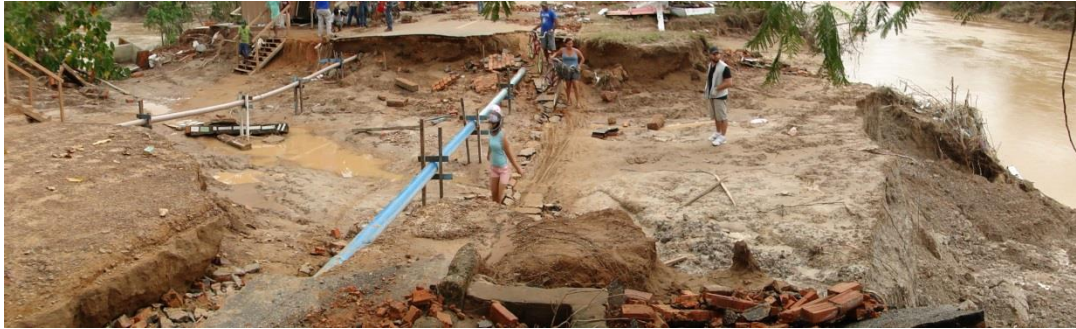
Figura 16. Vala oriunda da erosão do rio durante a inundação. Rua dos Catraieiros.
