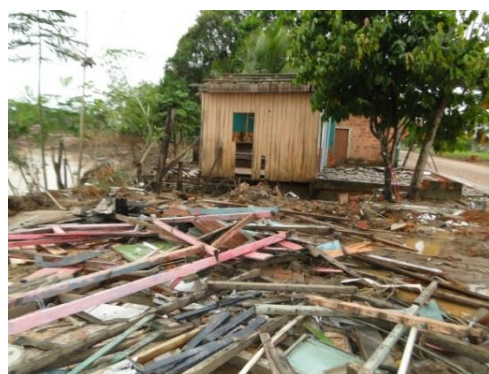
Figura 22. Desmonte de imóveis e reaproveitamento de material.
