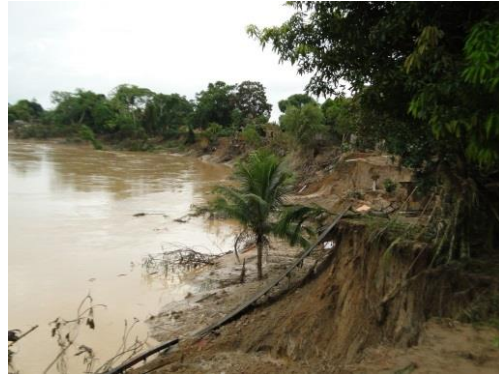
Figura 12. Taludes fluviais erodidos
