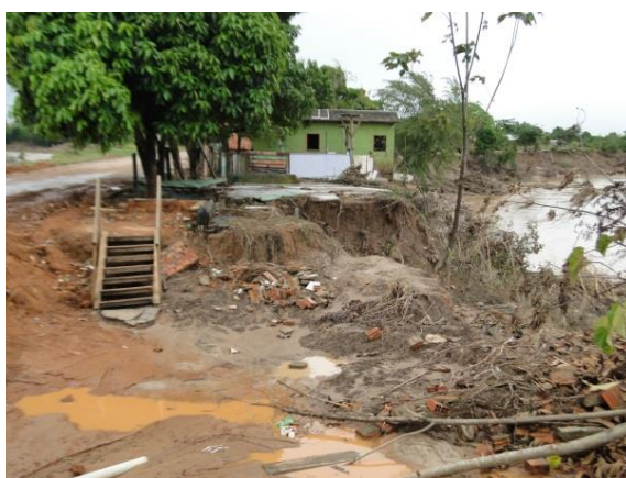
Figura 23. Erosão dos taludes fluviais. Rua dos Catraieiros.
