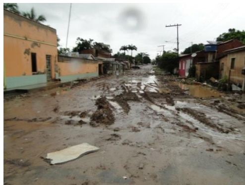
Figura 33. Rua transversal, inundada, com depósitos de sedimentos.
