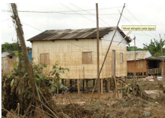
Figura 8. Marca d'água em imóvel residencial, construído sobre palafitas. Bairro 28 de Maio.
