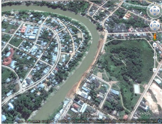
Figura 56. Extenso trecho erodido na rua Rolando Moreira. Imagem Google, 07/abril/2015.
