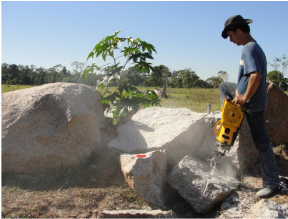
Figura 02 – Retirada de amostras com auxílio de martetele a gasolina.
