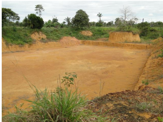
Figura 32. Ampla escavação de material lateritizado.
