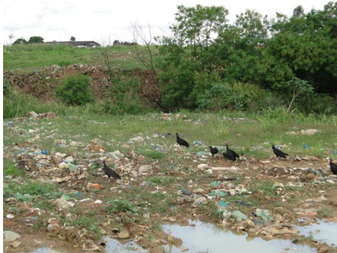
Figura 16. Escavação para despejo de lixo. Acumulação de água pluvial e chorume.
