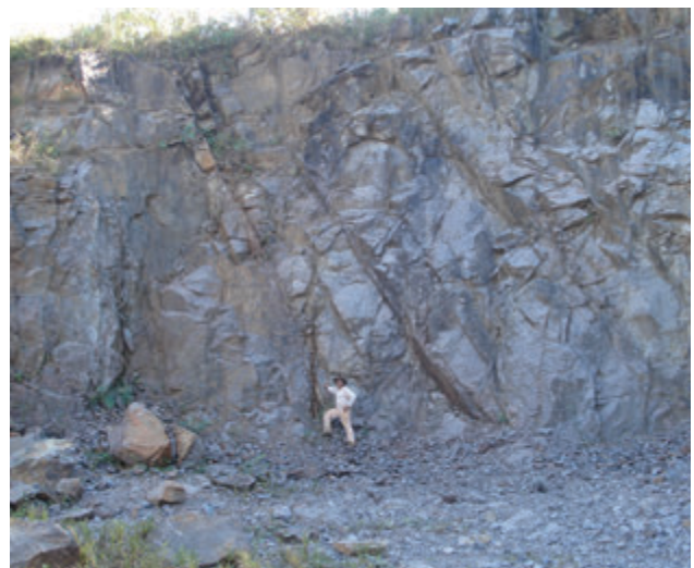
Figura 4.37 – Rochas granitoides fraturadas, pedra Tec-Pedra, zona rural de Porto Velho.
