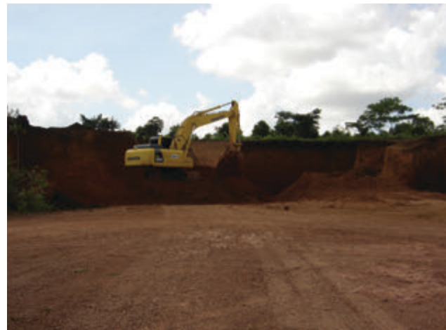
Figura 2.5 - Retirada de cascalho laterítico para pavimentação de estradas vicinais. Estrada de Santo Antônio.
