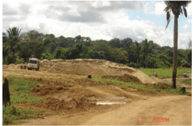
Figura 4.5. – O carregamento de caminhões após a secagem e separação por granulometria, próximo ao rio Candeias.
