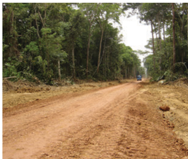
Figura 4.43 – Material laterítico (cascalho laterítico) utilizado como pavimento de uma estrada vicinal na zona rural de Porto Velho.
