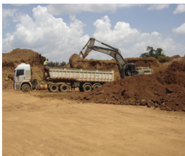
Figura 4.47 – Carregamento de material na mina da margem esquerda do rio Madeira.
