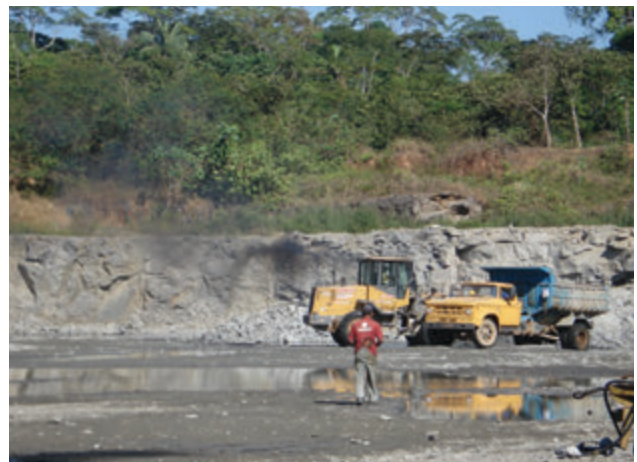
Figura 4.35 – Escavadeira retirando material para carregamento em caminhões, na região da cachoeira de Santo Antônio.
