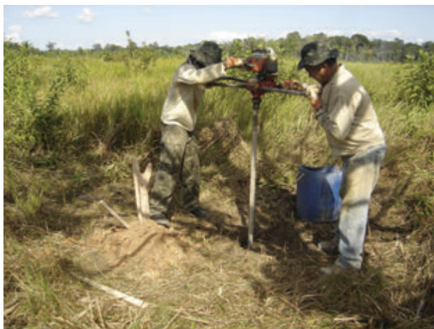
Figura 4.16 – Sondagem rotativa com trado tipo SPT.
