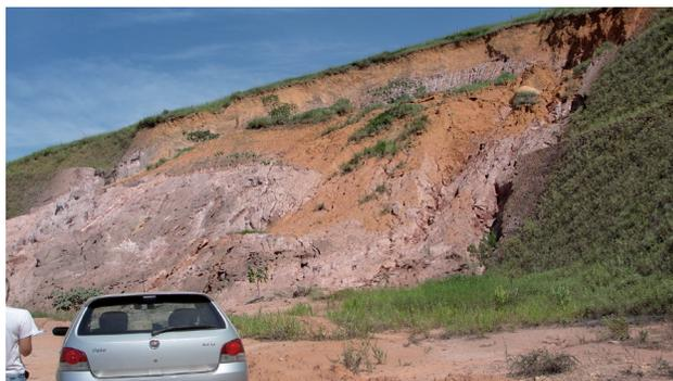
**Figura 4.67** - Deslizamento em talude de corte nos terrenos granitoides intensamente deformados. Problema bastante comum, principalmente se a evolução pedogenética for incipiente (município de Mimoso do Sul). Foto: Marceley Machado, 2010.
