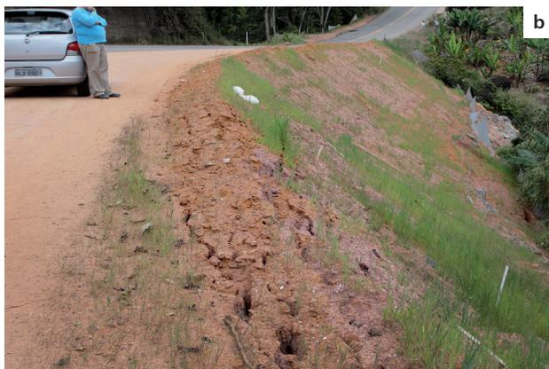
**Figura 4.68** - Trecho da rodovia ES-261 com novo traçado: (a) reconstrução da margem com material pouco evoluído; (b) presença de fendas no aterro indicando a inadequabilidade do material utilizado na recuperação da rodovia. Município de Santa Teresa. Fotos: Marceley Machado, 2010.
