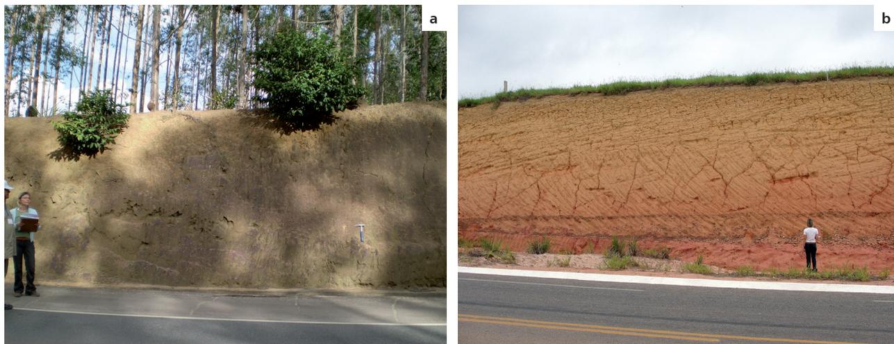
**Figura 4.19** - Talude de corte em pacote de materiais siltico-argiloso com boa estabilidade natural – baixa suscetibilidade a processos erosivos e de movimento de massa: **(a)** município de Aracruz; **(b)** município de Marataízes. Fotos: Marcely Machado, 2010.
