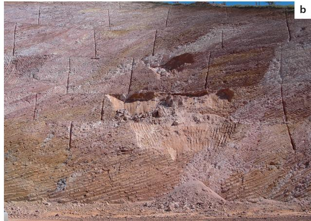
**Figura 4.86** - Escorregamentos em taludes de corte de estradas: **(a)** muro de gabião: medida estrutural para contenção do escorregamento planar de grande dimensão (município de Castelo); **(b)** escorregamentos planares em talude de corte executado em manto de alteração pouco evoluído e sem tratamento estrutural (município de Afonso Claudio). Fotos: Marceley Machado, 2010.
