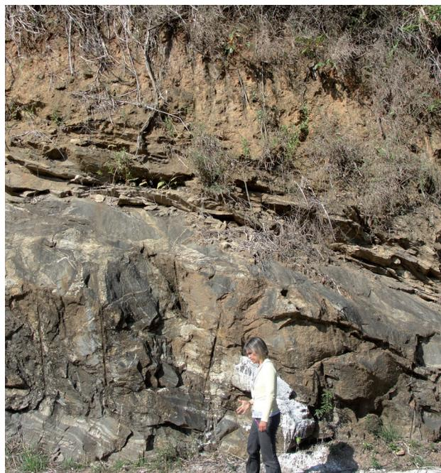
**Figura 4.53** - Talude de corte de rocha sã fraturada. Local susceptível a queda de blocos e deslocamentos (município de Mimosa do Sul). Foto: Marcelly Machado, 2010.
