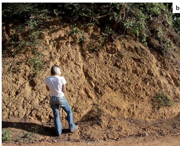
**Figura 4.57** - Taludes de corte em solo de pedogênese avançada com boa estabilidade natural, situados em estradas dos municípios de Ecoporanga **(a)** e Iúna **(b)**. Fotos: Marcelly Machado, 2010.
