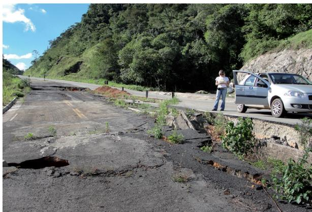
**Figura 4.69** - Solapamento de estrada após utilização de solo pouco evoluído para a constituição do aterro (município de Muniz Freire). Foto: Marceley Machado, 2010.
