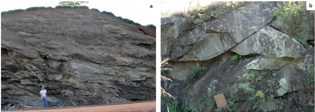
**Figura 4.83** - Taludes de corte em rochas muito deformadas: **(a)** afloramento exibindo elevado grau de fraturamento e alto potencial a queda de blocos e deslocamentos (município de Cachoeiro do Itapemirim). **(b)** detalhe de cunha formada pelas discontinuidades estruturais (município de Conceição do Castelo). Fotos: Marcelly Machado, 2010.
