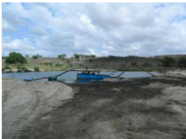
Foto 8.14 – Dragagem por barçaça com ancoragem fixa nos limites dos municípios de Ielmo Marinho e São Gonçalo do Amarante.
