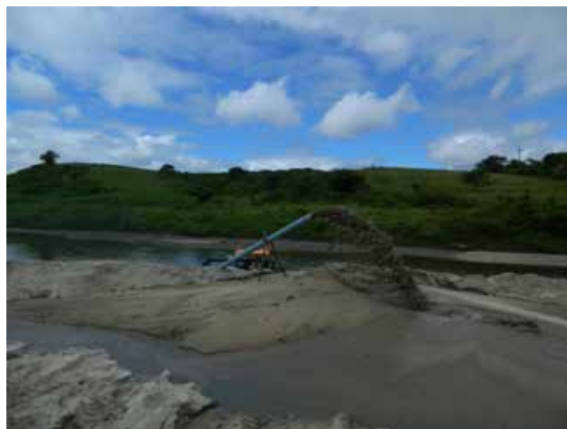
Foto 8.11 – Área produtora de areia, em leito de rio, depósito aluvionar, Rio Trairi no município de Monte Alegre, localidade de Quatro Bocas.
