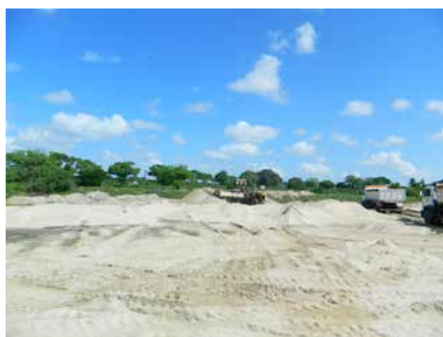
Foto 8.16 – Lavra com auxílio de pá carregadeira hidráulica no Rio Potengi, no limite entre os municípios de Ielmo Marinho e São Gonçalo do Amarante, localidade de Pitombeira.
