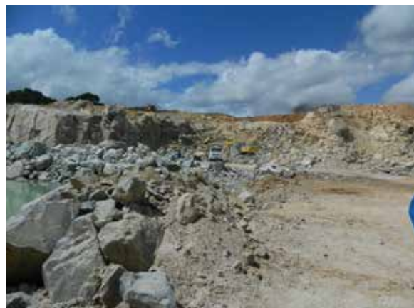
Foto 8.3 – Escavadeiras trabalhando sobre a pilha de rocha desmontada, município de Macaíba, localidade de Jundiá.
