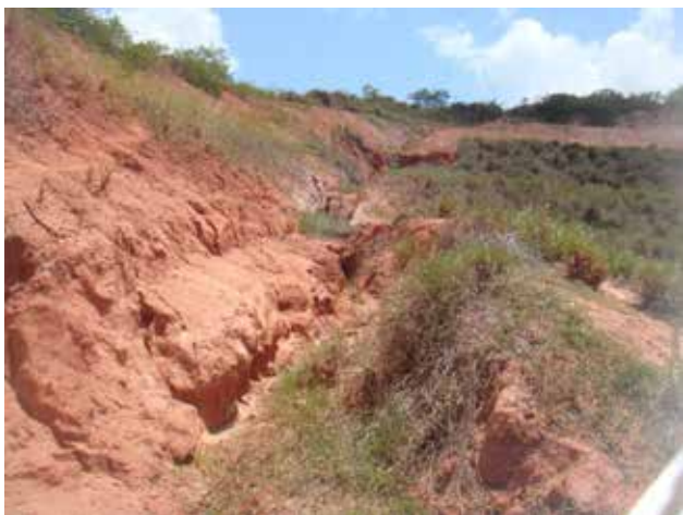
Foto 6.3 – Extração de argila, com sinais de processo erosivo, às margens da BR-101 em Ceará Mirim.
