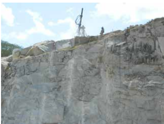
Foto 8.4 – Perfuração da rocha para carregamento com explosivo, município de São Gonçalo do Amarante, localidade Serrinha de Cima.
