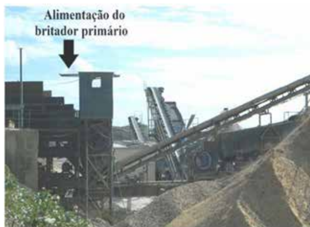
Foto 8.5 – Etapa de britagem e rebitagem, município de Macaíba, localidade de Jundiá.
