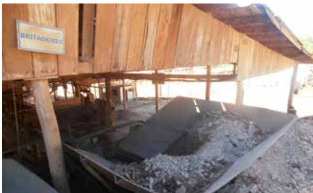
Figura 8.2 – Descarregamento do material proveniente da lavra nos alimentadores dos britadores de mandíbulas, na usina antiga da Companhia de Mineração de Rondônia – CMR.
