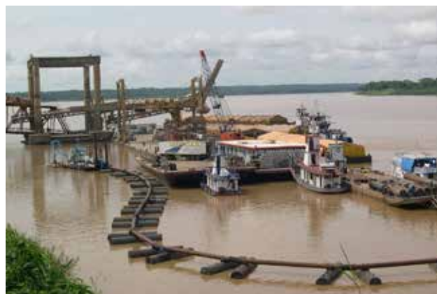
Figura 2.1 – Vista geral do Porto Organizado de Porto Velho. Fonte: Sociedade de Portos e Hidrovias do Estado de Rondônia – SOPH.
