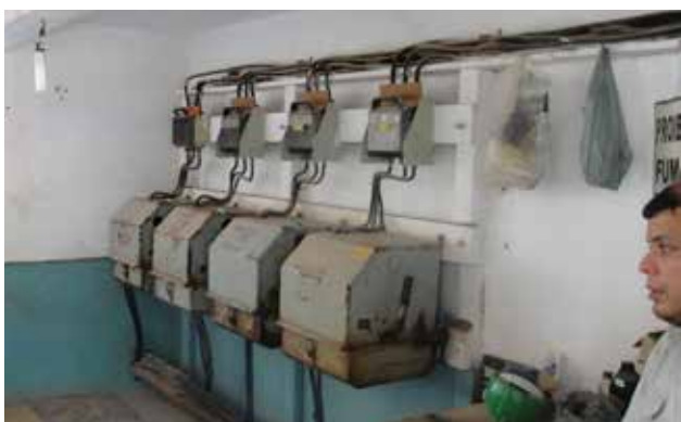
Figura 8.8 – Cabine de comando do circuito de beneficiamento da usina antiga da Companhia de Mineração de Rondônia – CMR.
