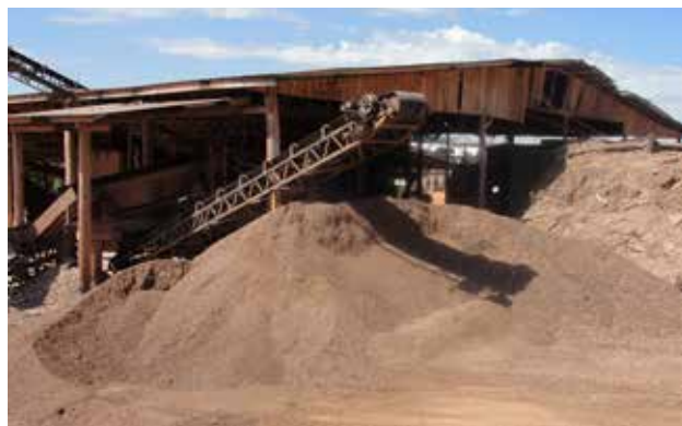
Figura 8.4 – Undersize da peneira vibratória sendo depositado na pilha de estoque temporária, antes de ser utilizado em recuperação de estrada e/ou aterro.
