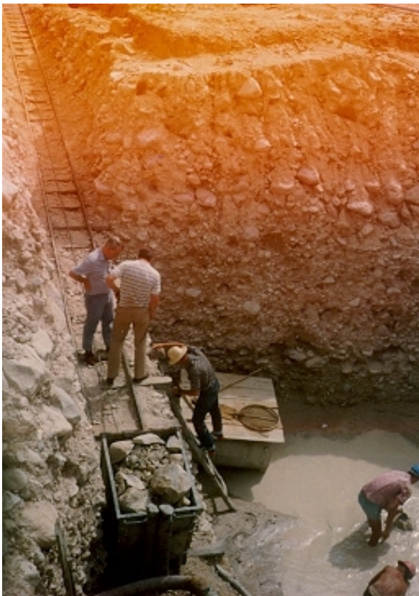
Foto 8 - Cata 8 - Zona superior de Cascalho N-3. Vagonete sobre trilho para retirada dos blocos maiores de cascalho que entram no processo de beneficiamento
