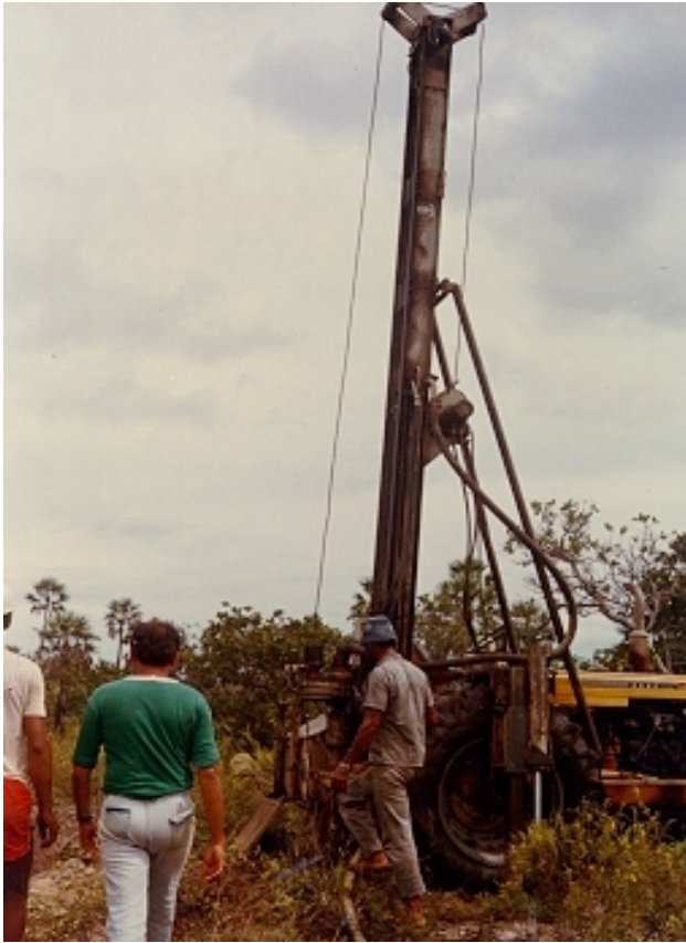
Foto 13 - Sonda roto-percussiva "ROCKY" em operação
