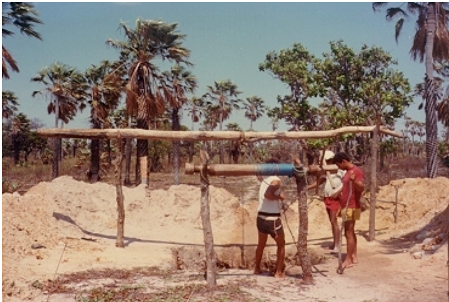
Foto 12 - Operação de abertura de poço manual exploratório para retirada do cascalho para beneficiamento
