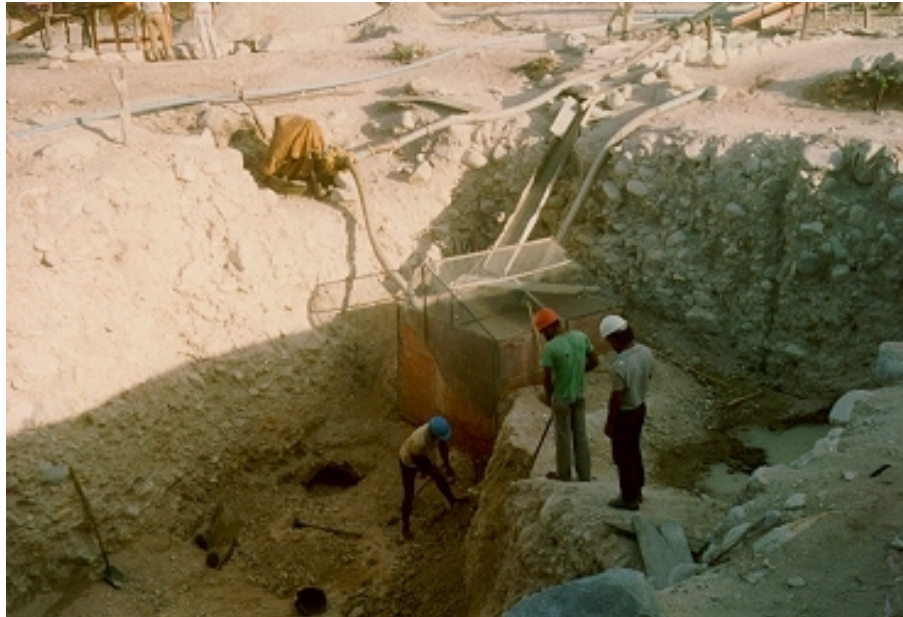
Foto 7 - Cata 9 - Setor Pega - Operações de beneficiamento na zona superior de cascalho N-3. Vê-se no fundo da cata a caixa separadora do cascalho com tela na sua parte superior. Em cima, bomba de sucção do material da caixa.
