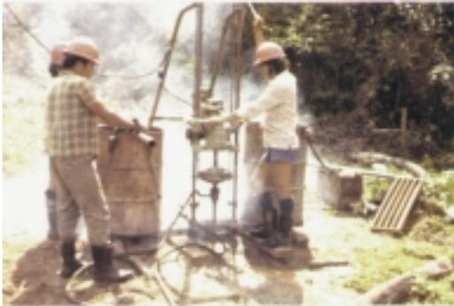
**Foto 4** – Operação com sonda rotativa diamantada
