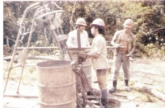
**Foto 5** – Operação com sonda rotativa, em fase de manobra
