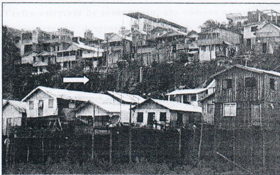
Figura 18 – Detalhe da situação das casas em área de encosta interdita pela Defesa Civil de Manaus, no bairro dos Educandos, próximo à Feira da PANAIR.
