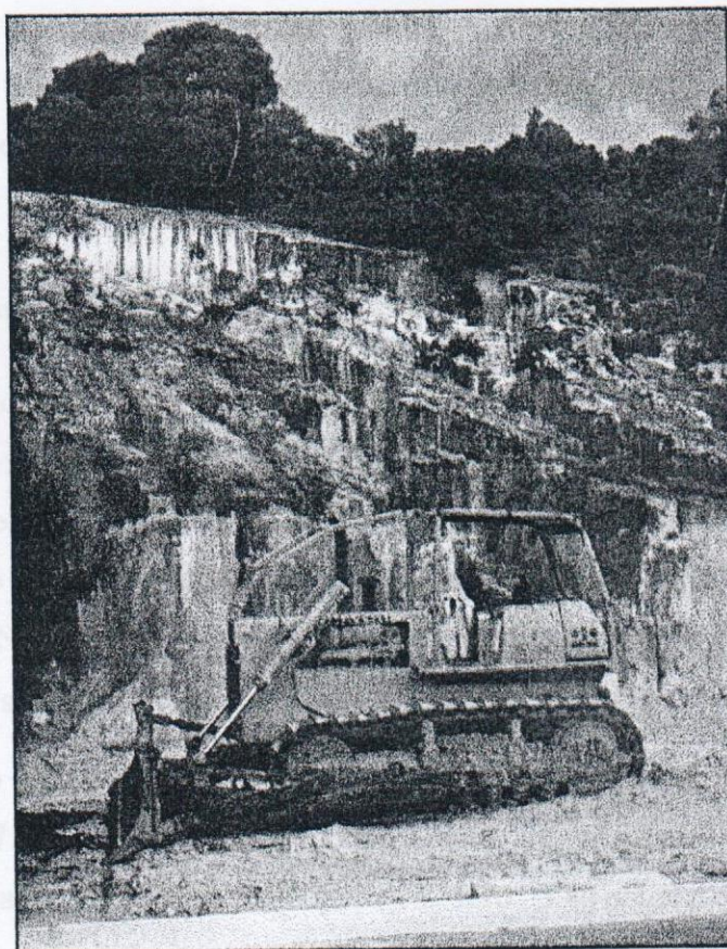
Figura 7 – Ravinas controladas por estruturas NW. Encosta a montante das instalações da PETROBRÁS (Ponto 2 – Mapa de Distribuição dos Processos Erosivos).
