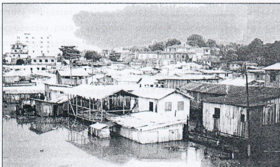
Figura 11 – Casas do tipo palafitas construídas na planície de inundação do igarapé do Quarenta, bairro Morro da Liberdade.
