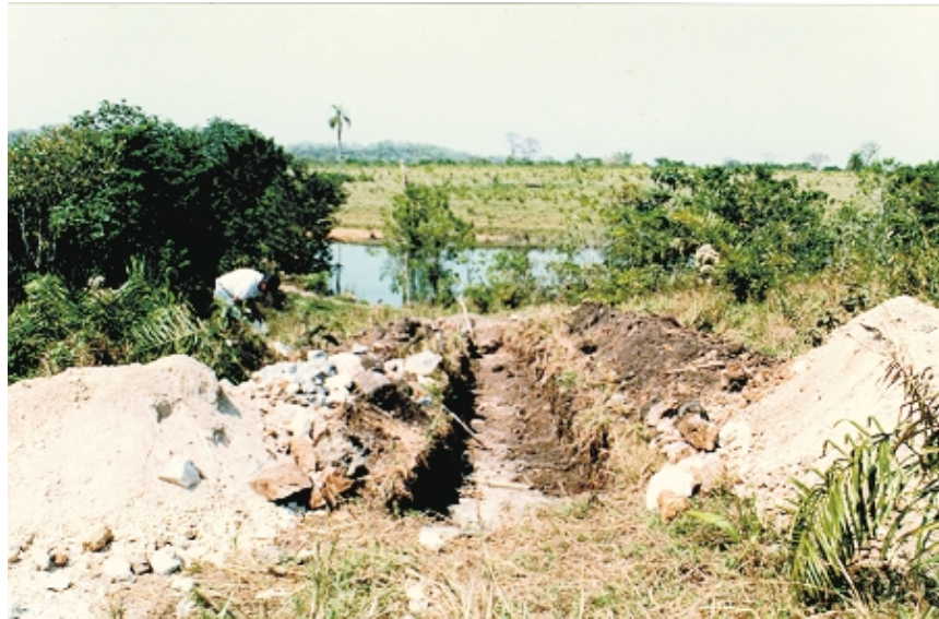
Foto 11 - Aspecto das escavações da Trincheira T4, na Fazenda Ressaca.
