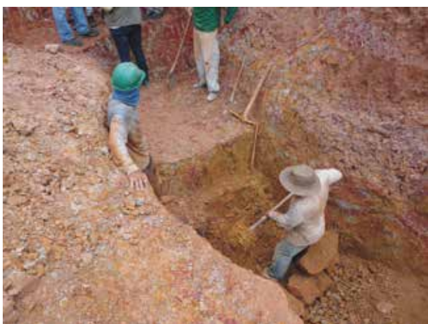
Foto 5.28 – Garimpo do Mamoeiro – Cava onde está sendo feito o rebaixamento da bancada que contém o nível argiloso, objetivando-se atingir a “laje” – diabásio (foto feita em maio/2013).
