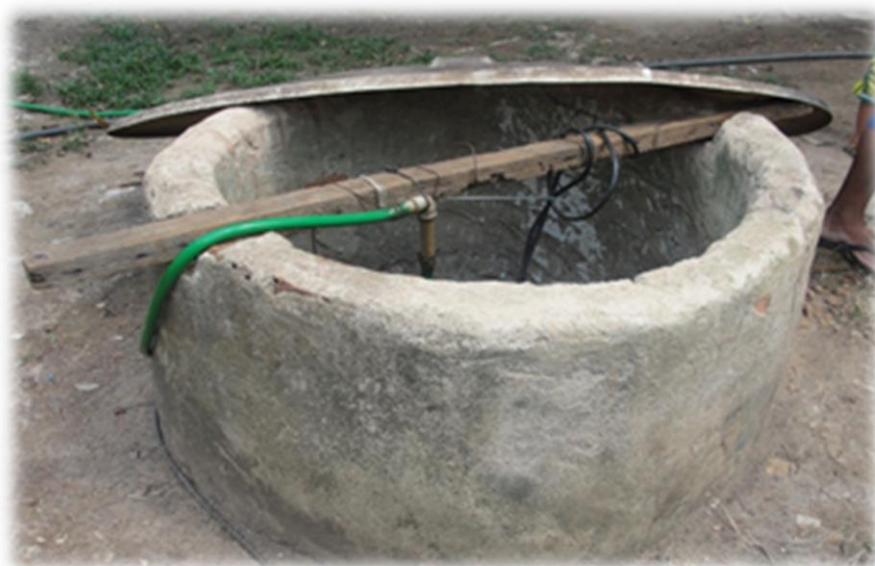
Figura 10 - Exemplo de poço do tipo Amazonas amplamente encontrado na área alvo dos estudos.
