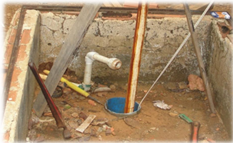
Figura 9 - Exemplo de poço do tipo tubular particular encontrado na área alvo dos estudos.
