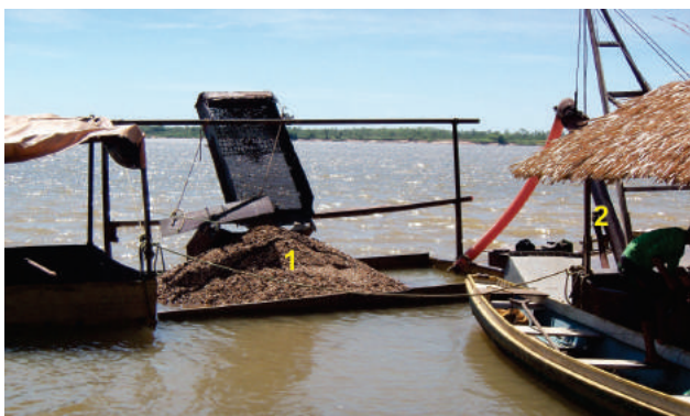
Figura 4.2 - Barcaça com agregados (1), sendo descarregada com bombas de sucção (2) para planta de classificação.
