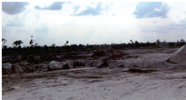
Figura 4.8 - Retirada da camada superior do solo, rica em matéria orgânica, para posterior extração do horizonte de areia branca.
