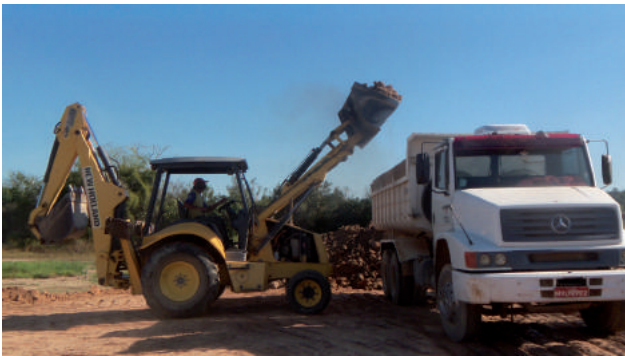
Figura 4.14 – Retroescavadeira carregando de argila caçamba truncada, em via de transporte para pátio da cerâmica.
