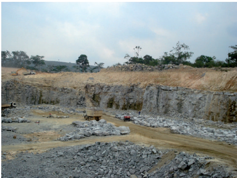
Figura 7.3 – Visão geral de pedreira de brita da região de Eldorado de Carajás, rodovia PA-275. Paredes verticalizadas e espesso capeamento de solo favorecem a atuação dos processos erosivos e evidenciam a instabilidade do talude (estação JG-162).
