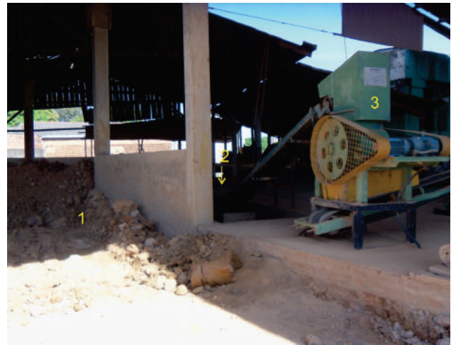
Figura 4.20- Misturador e processo de umidificação com aspersão de água.
