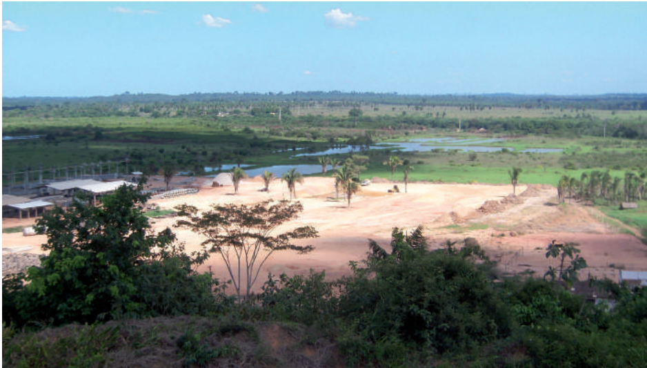
Figura 3.22 - Paisagem mostrando utilização de saibro em aterro de planície aluvionária, visando instalações industriais no Distrito Cidade Nova, em Marabá.
