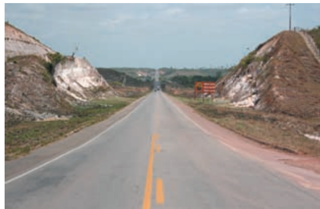
Figura 3.13 – Tabuleiros levemente ondulados, sulcados por drenagem, típicos da Zona Bragantina (rodovia PA-242, próximo à cidade de Igarapé-Açu).
