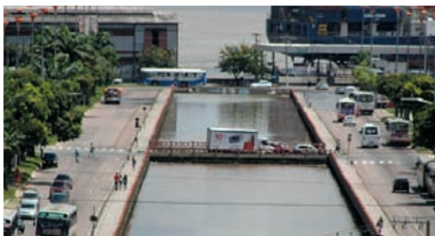
Figura 8.11 – Impermeabilização do solo e retificação de canais na Região Metropolitana de Belém.
