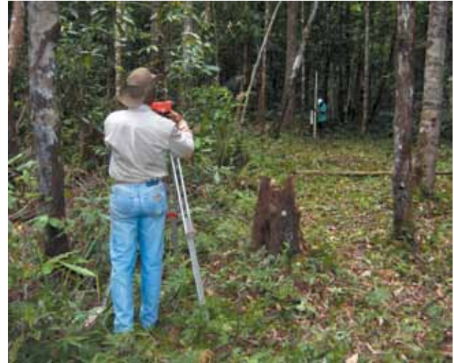
Figura 5.17 - Nivelamento Topográfico para Levantamento de Seção Transversal.
