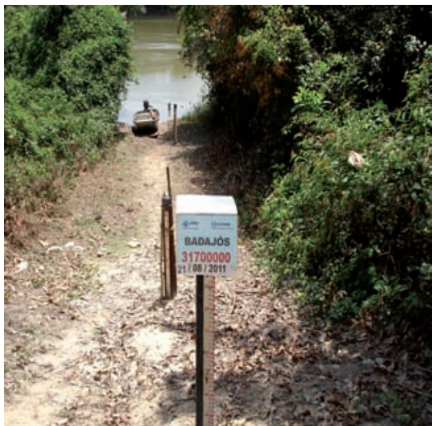
Figura 5.6 - Estação Fluviométrica (Réguas) de Badajós.
