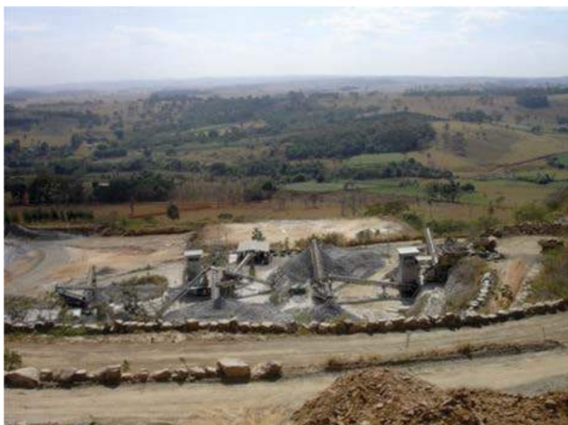
Foto 6.15 – Instalações de britagem, município de Goianópolis.
