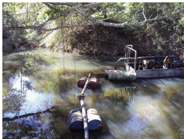
Foto 4.2 – Dragagem no rio Uru, município de Itaberaí.
