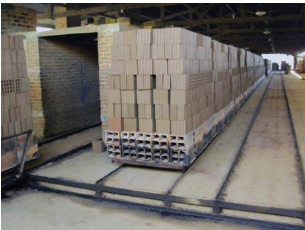
Foto 6.11 – Forno Contínuo, para queima de tijolos furados, cerâmica em Anápolis.
