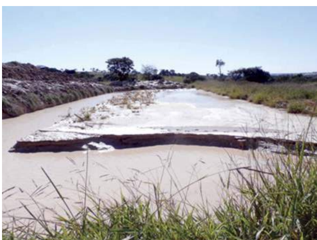
Foto 7.7 – Bacia de rejeito, operando em circuito fechado, lavra no município de Professor Jamil.
