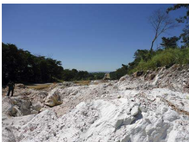
Foto 4.27 – Exposição de rocha metacalcária durante as obras de duplicação da BR-060, município de Indiara.
