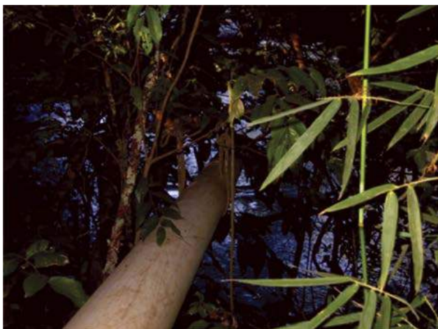
Foto 7.4 – Água de retorno em tubulação, sendo lançada no leito do rio Dourados, sem prejudicar as suas margens, atendendo aos projetos técnicos, município de Professor Jamil.
