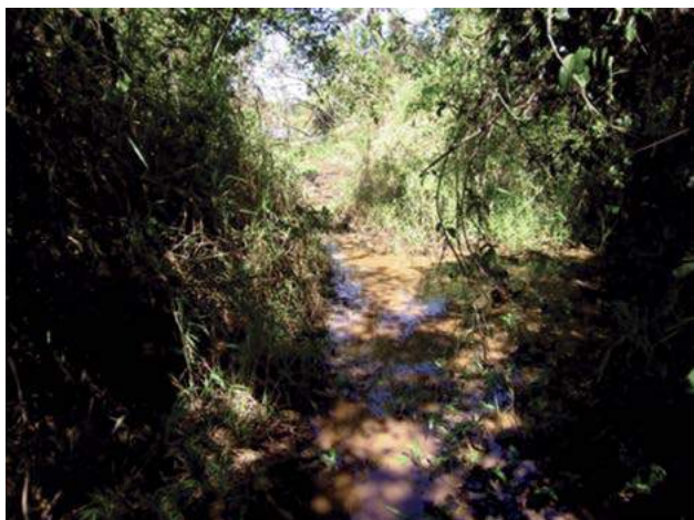
Foto 7.3 – Água de retorno escoando na superfície do terreno, podendo provocar a erosão das margens da drenagem, rio Meia-Ponte, município de Professor Jamil.
