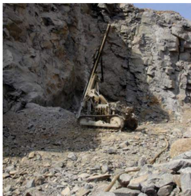
Foto 6.14 – Operação de perfuração para desmonte por explosivos, município de Goianópolis.
