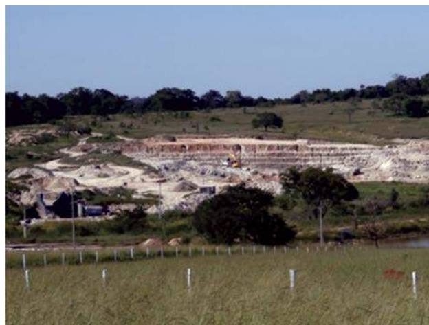
Foto 7.5 – Vista panorâmica de lavra de rocha granitoide (para areia), mostrando ao fundo as bancadas regulares em meia encosta, e, no primeiro plano, cerca delimitando a área de APP a ser reflorestada, município de Piracanjuba.
