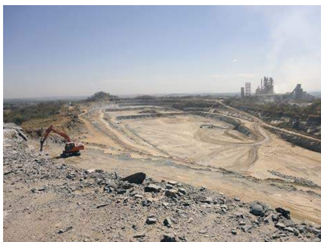
Foto 4.22 – Lavra de metacalcário e usina cimenteira, município de Cezarina.
