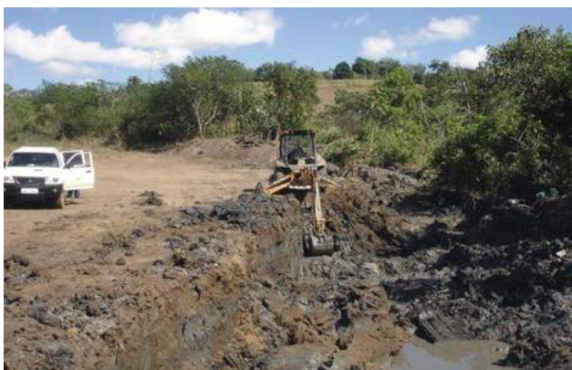
Fotos 6.7 – Lavra de argila usando retroescavadeira, município de São Miguel do Passa Quatro.
