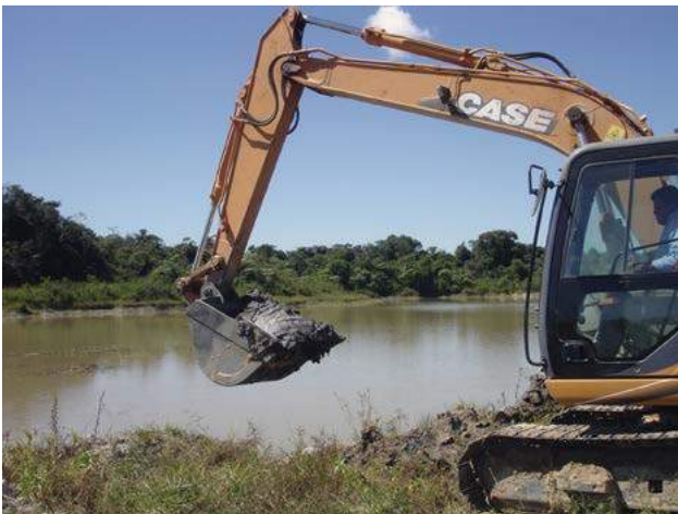
Foto 5.2 – Extração de argila na planície aluvionar do rio Jurubatuba, município de Silvânia.
