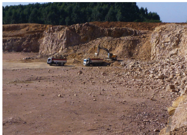
Figura 6.13 – Carregamento em extração em pedreira de granito para brita.
