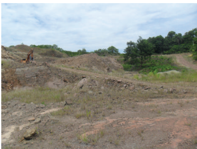
Figura 5.13 – Área de mineração de saibro de basalto ativa, onde nenhuma medida de recuperação concomitante foi constatada. Ponto GP – 015.
