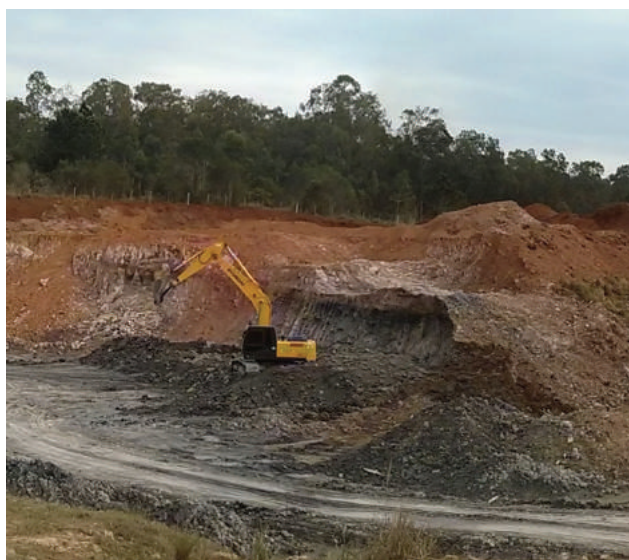
Figura 4.12 – Frente de lavra de argila em Alvorada (Formação Rio Bonito).
