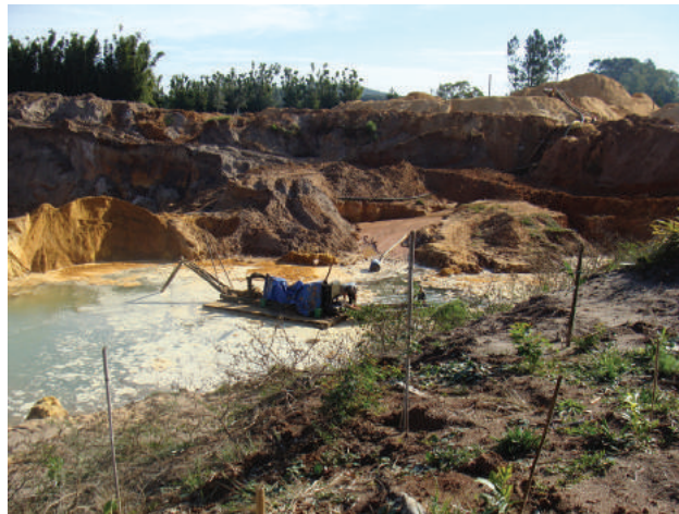
Figura 5.5 – Mineração de areia com o emprego de draga sem dispositivo de contenção de vazamentos de óleos e graxas, expondo o freático à contaminantes. Ponto GP-125.
