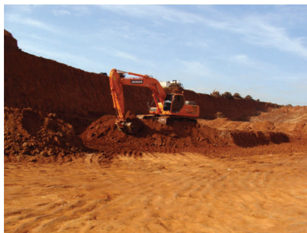
Figura 4.29 – Extração de material de empréstimo em rochas da Formação Pirambóia. Município de São Leopoldo, ponto GP-080.
