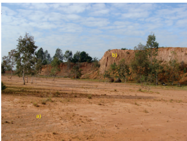
Figura 5.14 – Exemplo de ação de recuperação insuficiente e inadequada em área degradada pela mineração de material de empréstimo: a) inócuo tentativa de vegetar a antiga praça de mineração com poucas mudas arbóreas e sem a deposição de solo orgânico para corrigir o substrato de natureza arenosa e bastante erodível; b) ausência de medidas de estabilização dos taludes e controle da erosão, permitindo a continuidade da degradação na área mesmo sem a mineração. Ponto GP – 078.
