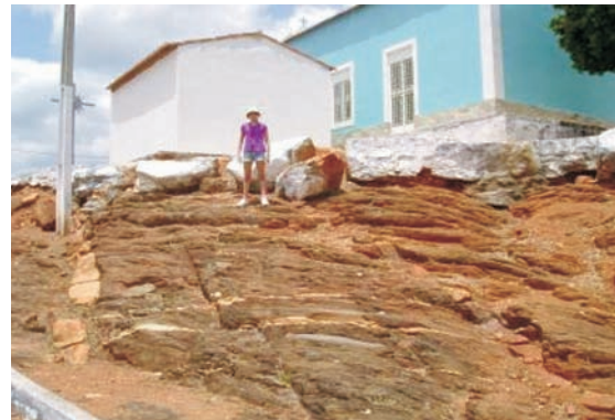
Figura 66 - Base/alicerce da capela, formado por rochas do Complexo Caicó intrudido por diques graníticos.
