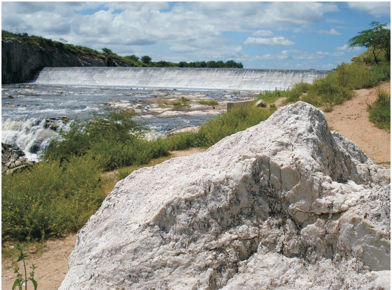
Figura 127 - Vista do açude Boqueirão com o sangradouro ao fundo. Em primeiro plano, parte de um pegmatito rico em biotita.
