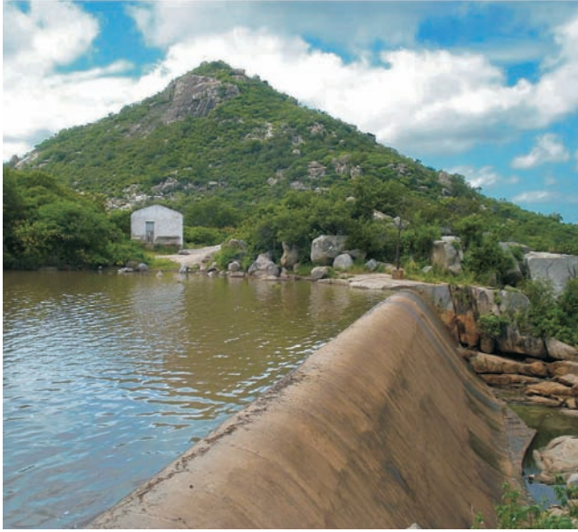
Figura 33 - Pico do Totoró formado predominantemente por granito porfírico ao lado do açude homônimo.
