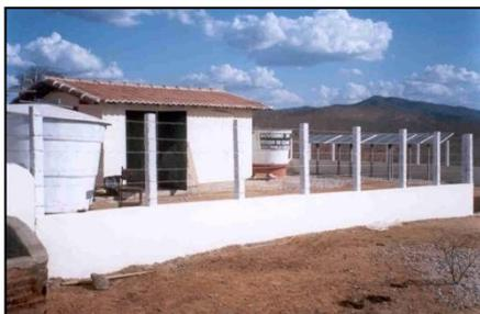
Os Sistemas Simplificados de Abastecimento construídos no semiárido nordestino são compostos pelo poço, de onde a água é sugada por uma bomba que funciona com energia elétrica ou com energia solar, obtida com a instalação de painéis solares.
