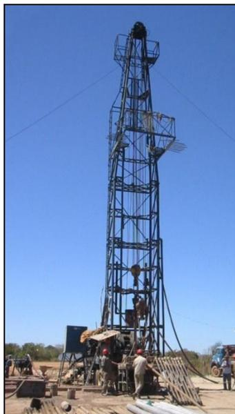
*Máquina perfuratriz chamada de “sonda” executando a perfuração de um poço planejado pelo Serviço Geológico do Brasil - CPRM.*
