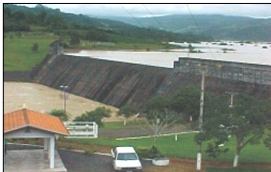
A barragem Sul integra um conjunto de barragens construídas para controlar as cheias no vale do rio Itajaí, em Santa Catarina.
