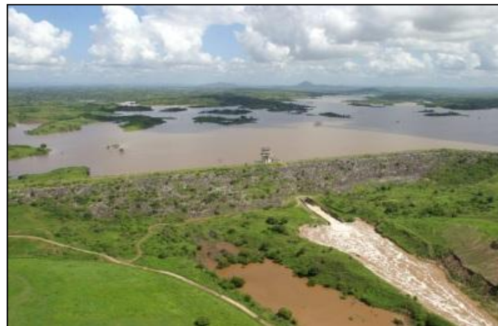
Barragem de Carpina construída para auxiliar o controle das enchentes na região metropolitana de Recife (PE).
