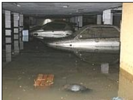
Veículos danificados em garagem inundada .
