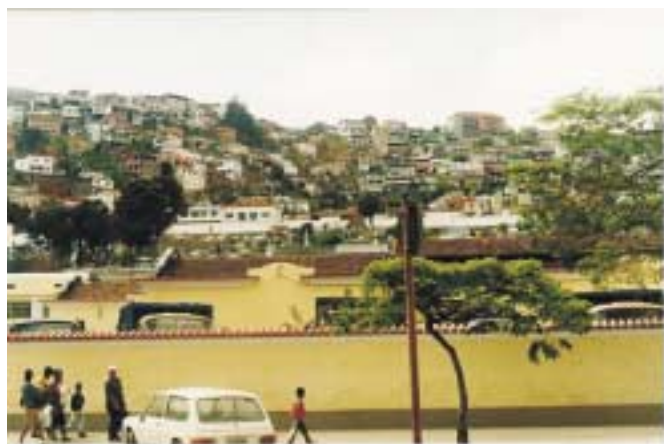
Foto 17 – Aspecto da ocupação urbana desordenada em encostas de alta declividade. Tal ocupação potencializa os processos de movimentos de massa, podendo acarretar graves danos materiais e perdas humanas. Centro de Nova Friburgo.
