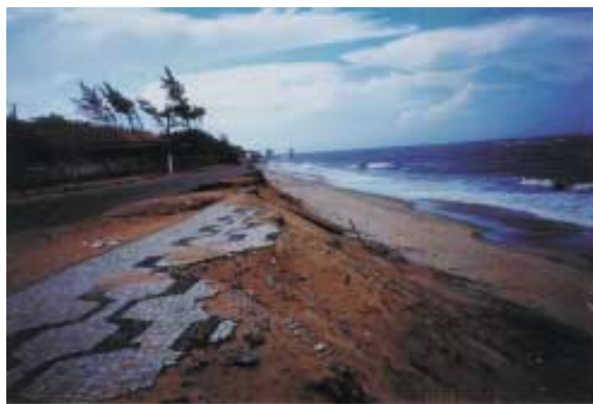
Foto 42: Aspectos da intensa erosão marinha, destruindo parte da malha urbana do distrito de Atafona, situado junto à desembocadura do rio Paraíba do Sul. Atafona.
