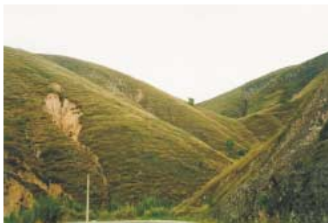
Foto 25 – Aspectos do intenso voçorocamento verificado em algumas áreas colinosas da depressão interplanáltica do médio vale do rio Paraíba do Sul. Estrada Getulândia - Barra Mansa (fazenda Vila Pepita).
