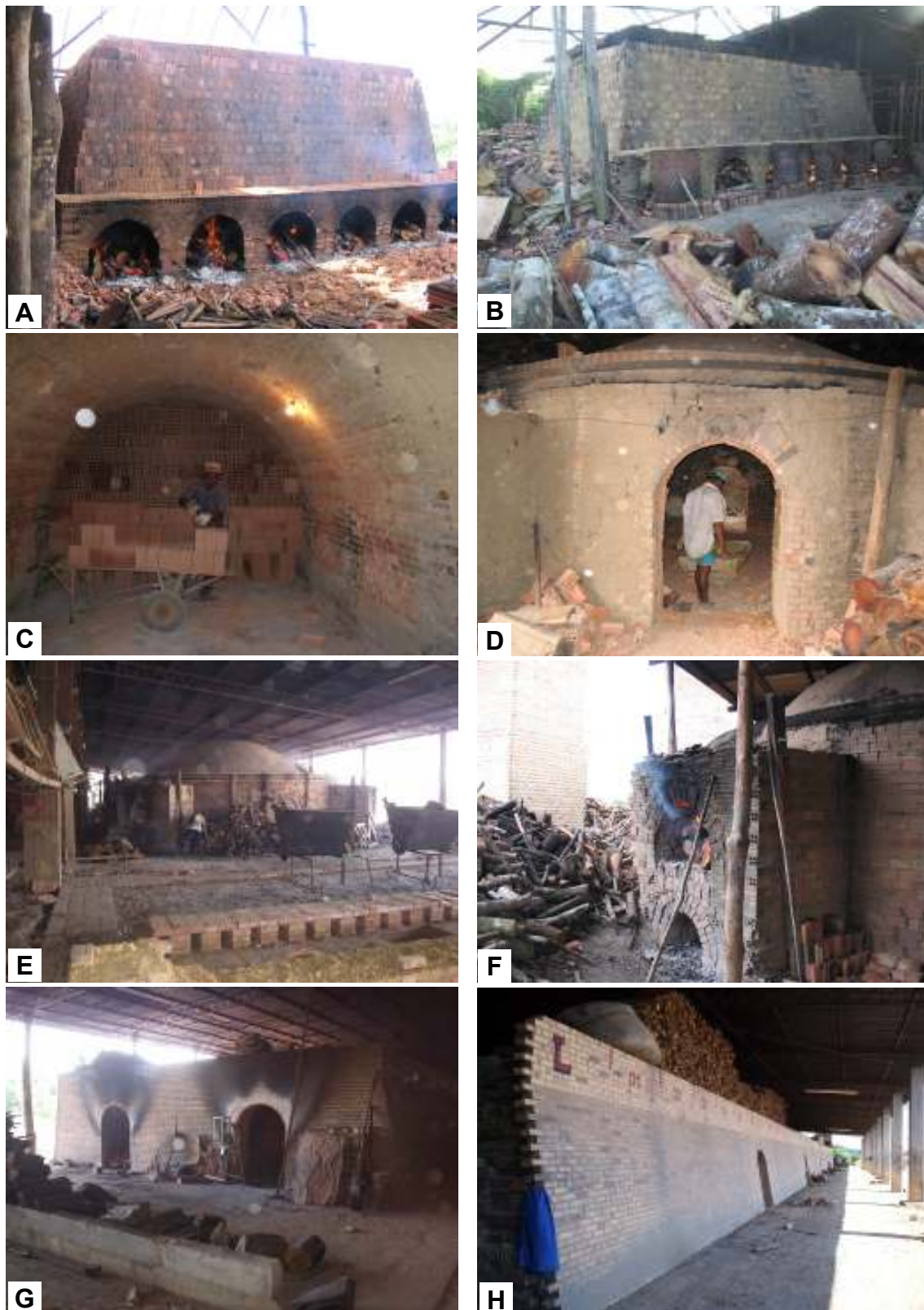
Figura 12.14 – Fornos: (A e B) Forno caieira é uma das características das micro-empresas; (C e D) Fase de arrumação para a queima; (E e F) Forno abóbada, mais comumente usado na região; e (G e H) forno semi-contínuo responsável por cerca de 30% da produção.
