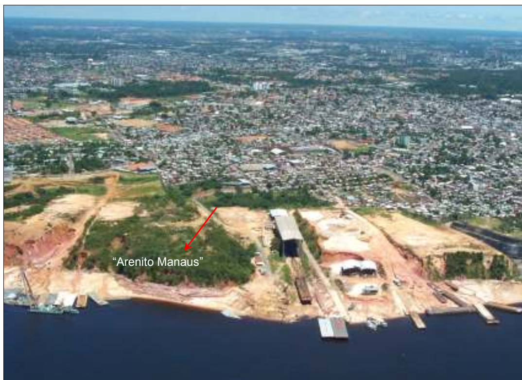
Figura 7.3 – Vista aérea da orla fluvial esquerda do rio Negro, onde aparecem barrancos com dezenas de metros de espessura e que representam perfis de alteração da Formação Alter do Chão (Kac I).
