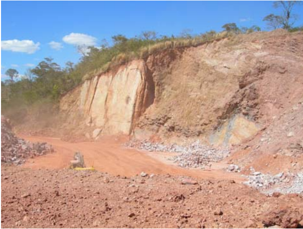
Foto 3.96 - Camadas de calcário (cc) e metassiltito (st) subverticais e de dolomito (do) subhorizontais. Emal-Unidade Paranatinga – Frente de Lavra Gonçalo. Paranatinga-MT.
