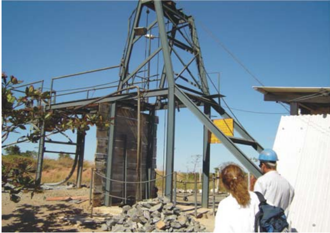
Figura 5.8 - Entrada do shaft de acesso à galeria.
