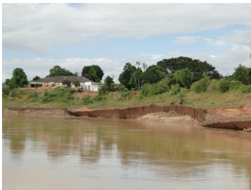
Figura 26. Muro de gravidade na orla fluvial de Brasileia. Ponto 110.
