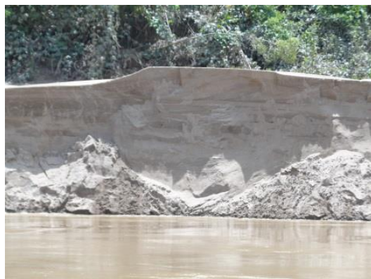
Figura 17. Banco arenoso em processo de desmoronamento. Ponto 127.
