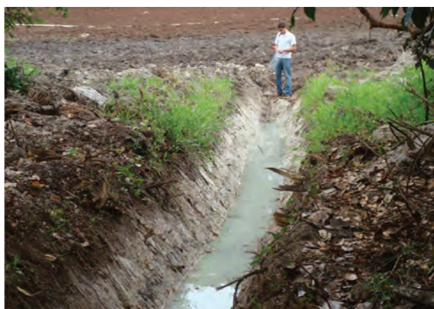
Foto 13 - Vala escavada exibindo a camada de argila, de coloração cinza, com espessura de 1,50m, da planície de inundação do Rio Pirapama. Depósito do Engenho do Meio, Cabo de Santo Agostinho.
