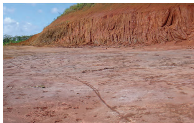
Foto 25 – Lavra de material de empréstimo de solos argilosos avermelhados resultante da alteração in situ de traquitos. Engenho do Meio/Cabo de Santo Agostinho.
