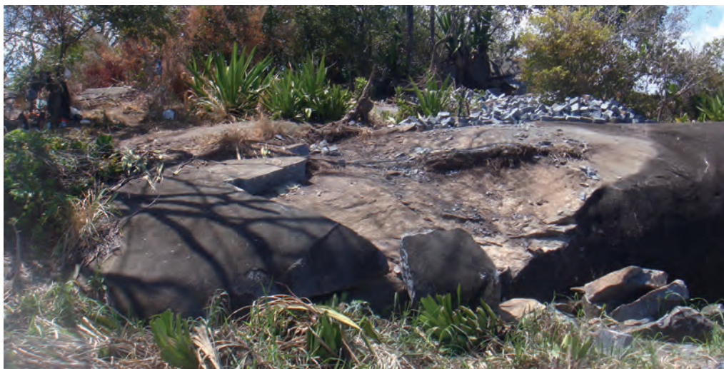
Foto 40 - Extração de Pedra de Talhe, na Rodovia da Integração, em Jaboatão dos Guararapes
