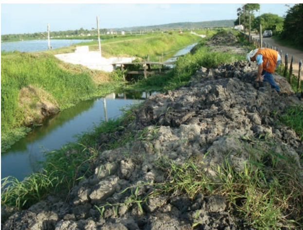
Figura 5.39 – Aspecto da escavação para viveiros (carcinocultura) onde foi encontrada a turfeira. Leito do rio Trairí em Nísia Floresta (RN). Afloramento MG288. Ponto de recurso mineral 184tf, no mapa geológico. Ocorrência não explorada.
