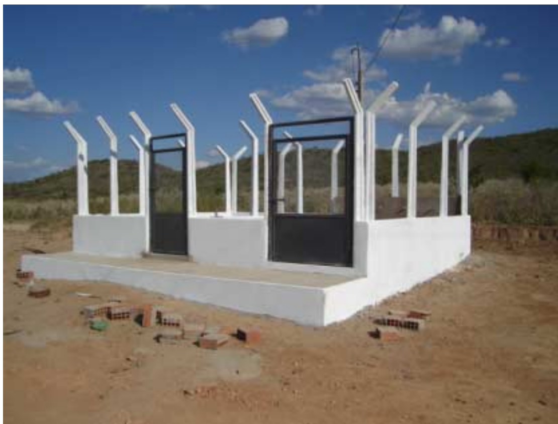
Foto 7.1 - Aspecto do SSA Vila Luziana em fase de conclusão
