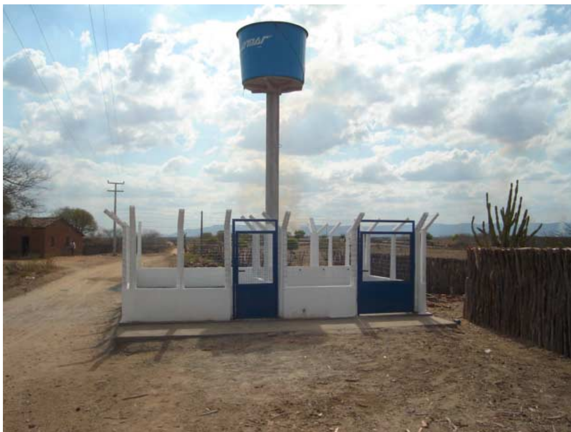
Foto 7.2 - Caixa d'água elevada - SSA em fase de conclusão
