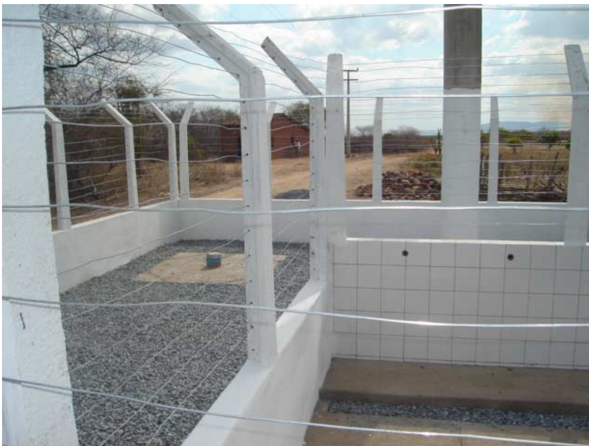
Foto 7.1 - Aspecto construtivo do SSA, mostrando recinto do poço e parte do chafariz
