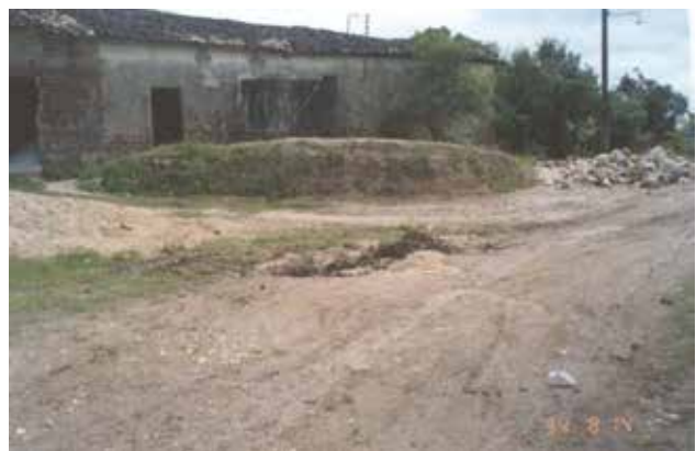
Foto 9.28 – Galpão onde se encontra abrigado todo o maquinário utilizado no beneficiamento da cal pela Mineração Coruripe da Cal - LTDA, cuja produção de corretivo de solo encontra-se atrelada à demanda dos mercados local e regional. Povoado de Coruripe, município de Palmeira dos Índios - AL.
