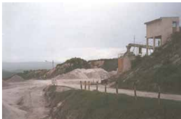
Foto 9.25 – Pátio de beneficiamento da Pedreira Porto da Folha (28 md), da MIBASA, na Serra da Laje. Município de Porto da Folha - SE.
