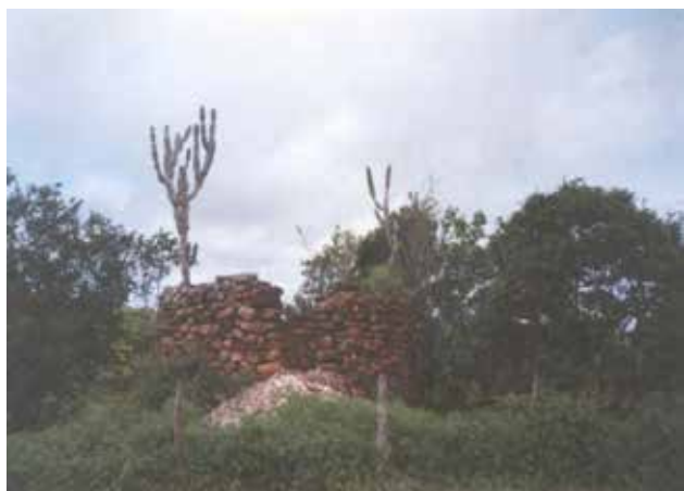
Foto 9.22 – Exemplo de um forno rudimentar a lenha, em ruínas, semelhante a tantos outros da região, utilizado para a fabricação de cal. Situado na sede da fazenda Aristides Zezinho (34 mm), o qual recebia o mármore das imediações para a calcinação. Município de Batalha - AL.
