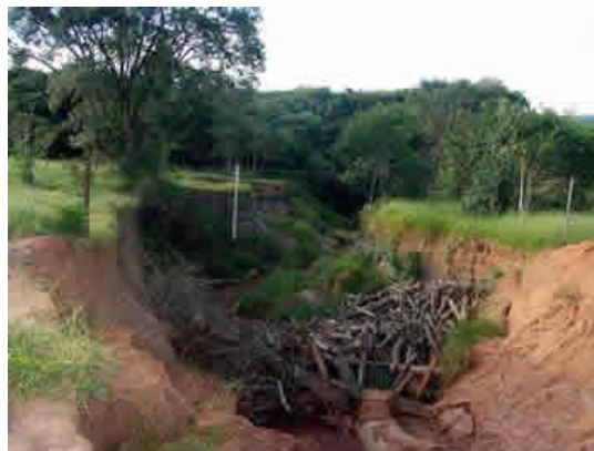
Figura 1 - Erosão do solo (Fonte: Portal São Francisco, 2013).
