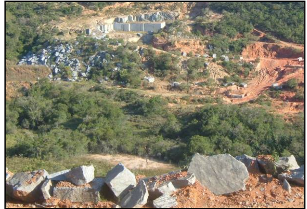
Foto 9.5: Visão geral de uma pedreira do Gnaiss Candeias (folha Oliveira), ponto IG 85, observando-se na parte frontal alguns blocos de rejeitos e, ao fundo, as paredes de onde são extraídos os blocos comerciais. Adicionalmente, observa-se a vegetação de mata ciliar sem a devida recomposição ambiental.
