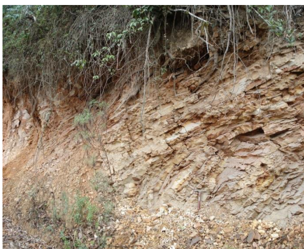
Figura 3.59: Vista lateral da porção frontal de um escorregamento. Escala martelo
