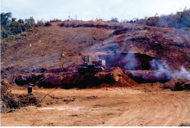
Fotografia 3.9 – Uma das frentes de lavra da jazida da Fazenda São Bento, município de Arraias-TO. UTM 309561/8570096 (PS-11).
