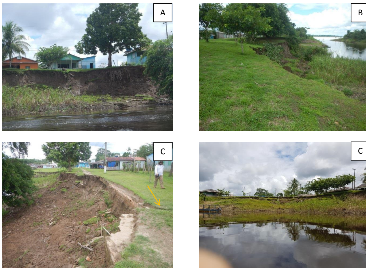
Figura 1 - Localização A,B,C e D: A – Vista frontal de Erosão Fluvial em afluente da margem esquerda do rio Madeira; B – Vista lateral de erosão fluvial, com rio Madeira ao fundo; C – Notar seta(em laranja) descarte de água servida, sobre a crista da erosão Fluvial, acelerando o processo erosivo, ; D – Notar Degraus de abatimento, em erosão fluvial localizado na zona leste do Distrito de Nazaré.
