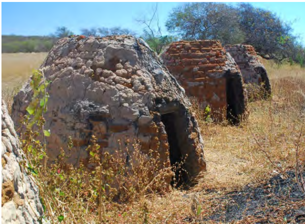
Figura 5.6 – Fornos artesanais para a produção de Cal a partir de calcários da Formação Santana (Caldeirão Grande do Piauí).
