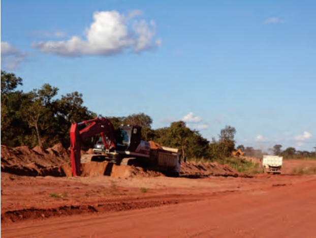
Foto 7.4 – Áreas de empréstimo de areia da Formação Furnas utilizadas na pavimentação da rodovia MT-251 (Coord. UTM 338574, 8372043).
