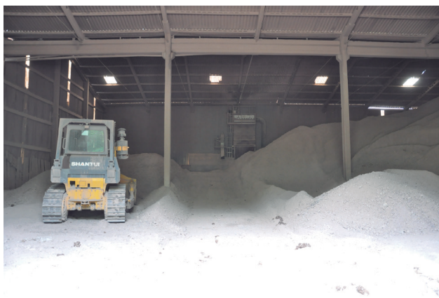
Figura 4.4 – Galpão destinado à homogeneização da matéria-prima.
