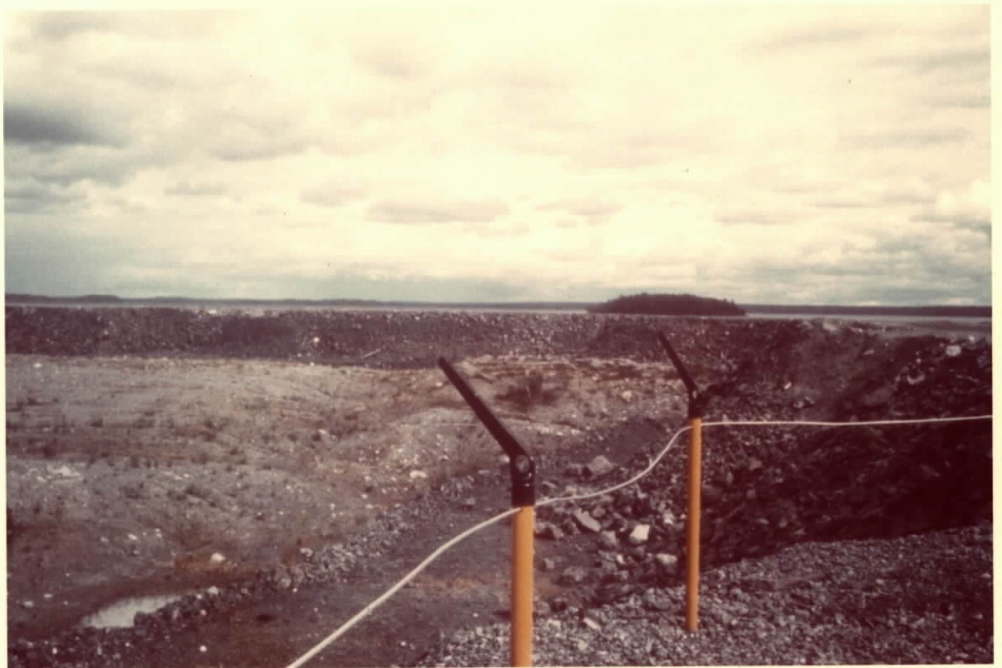
Dique artificial construído na mina de Ferro de Griffith para isolar a água de um lago. Ontário, Canadá.
