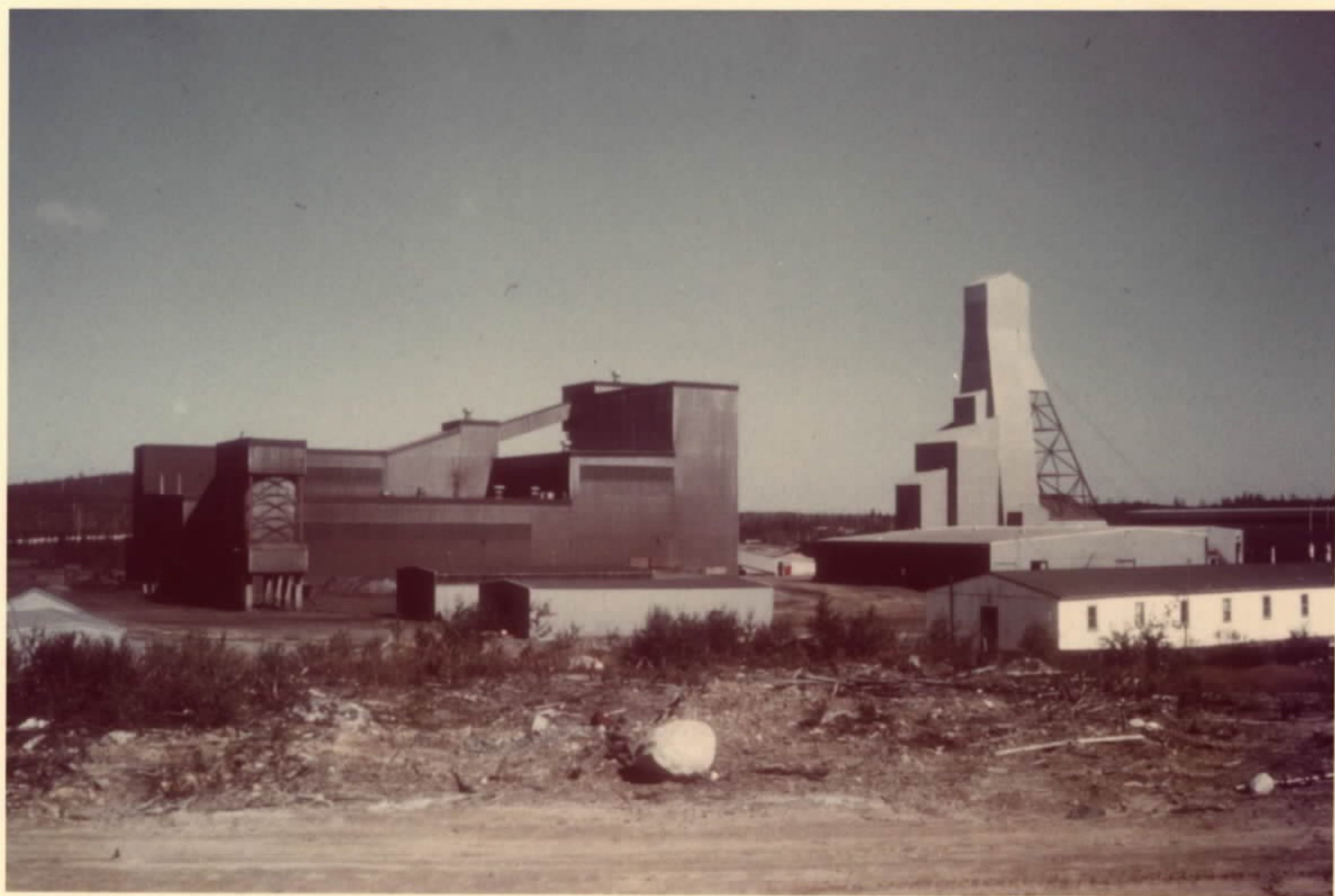
Torre do "shaft" da mina de Zn/Cu de Fox, área de Lynn Lake, Manitoba, Canadá.
