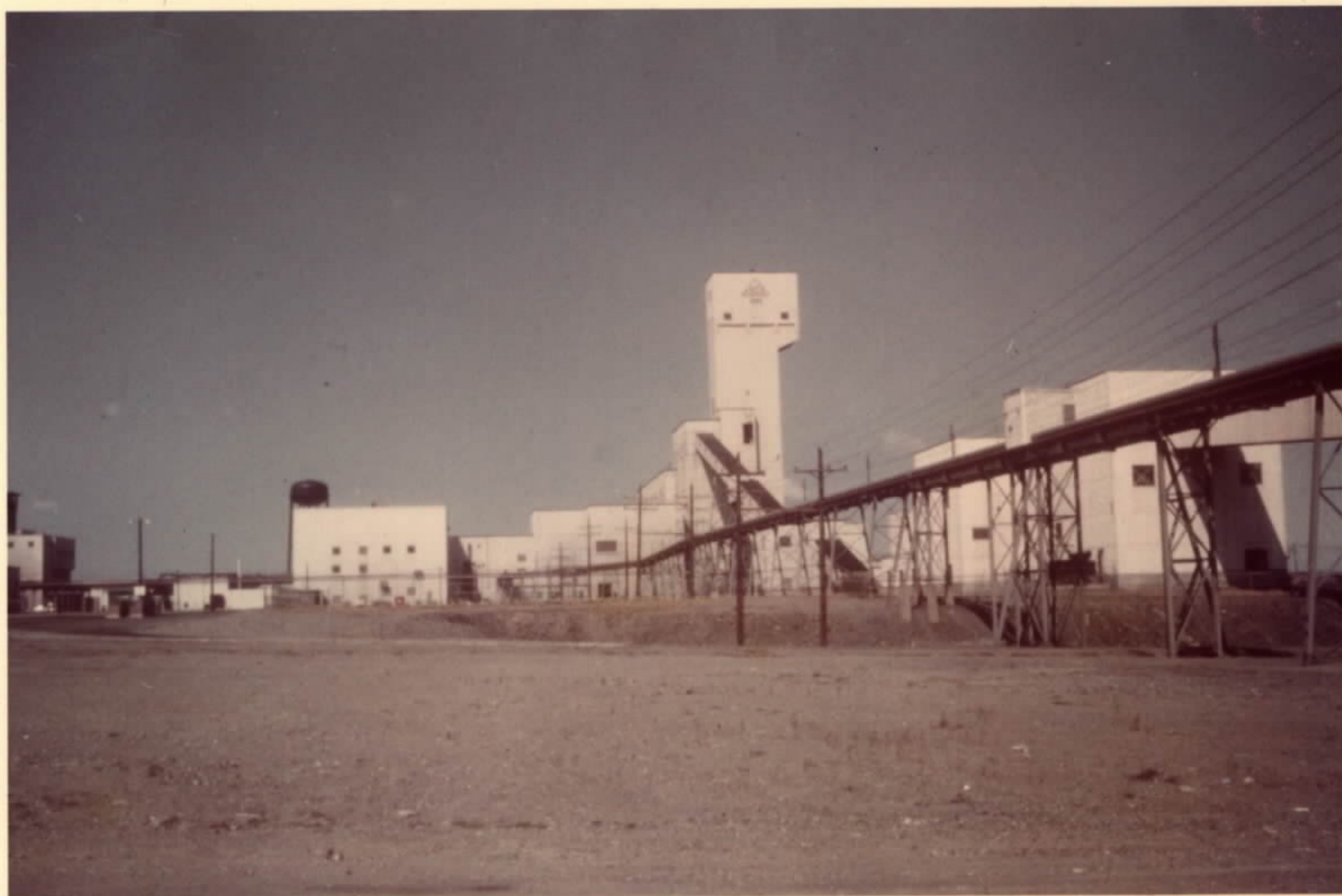
Torre do "shaft" da INCO, em Thompson, Manitoba, Canadá.
