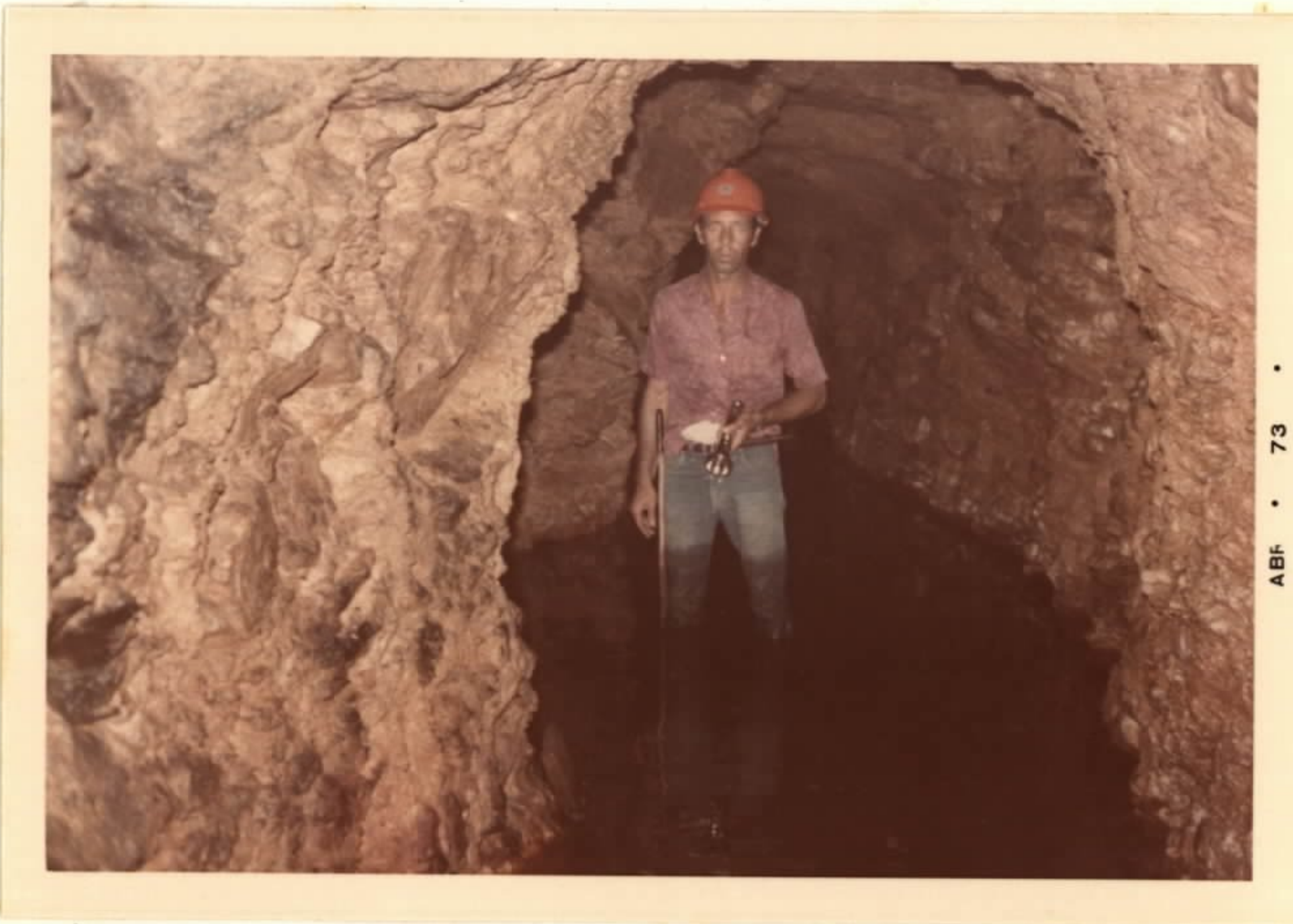
FOTO 8 - Aspecto da galeria, parcialmente inundada, aberta em veio de quartzo aurífero. Mina do Chapéu do Sol, Crixás, Goiás.
