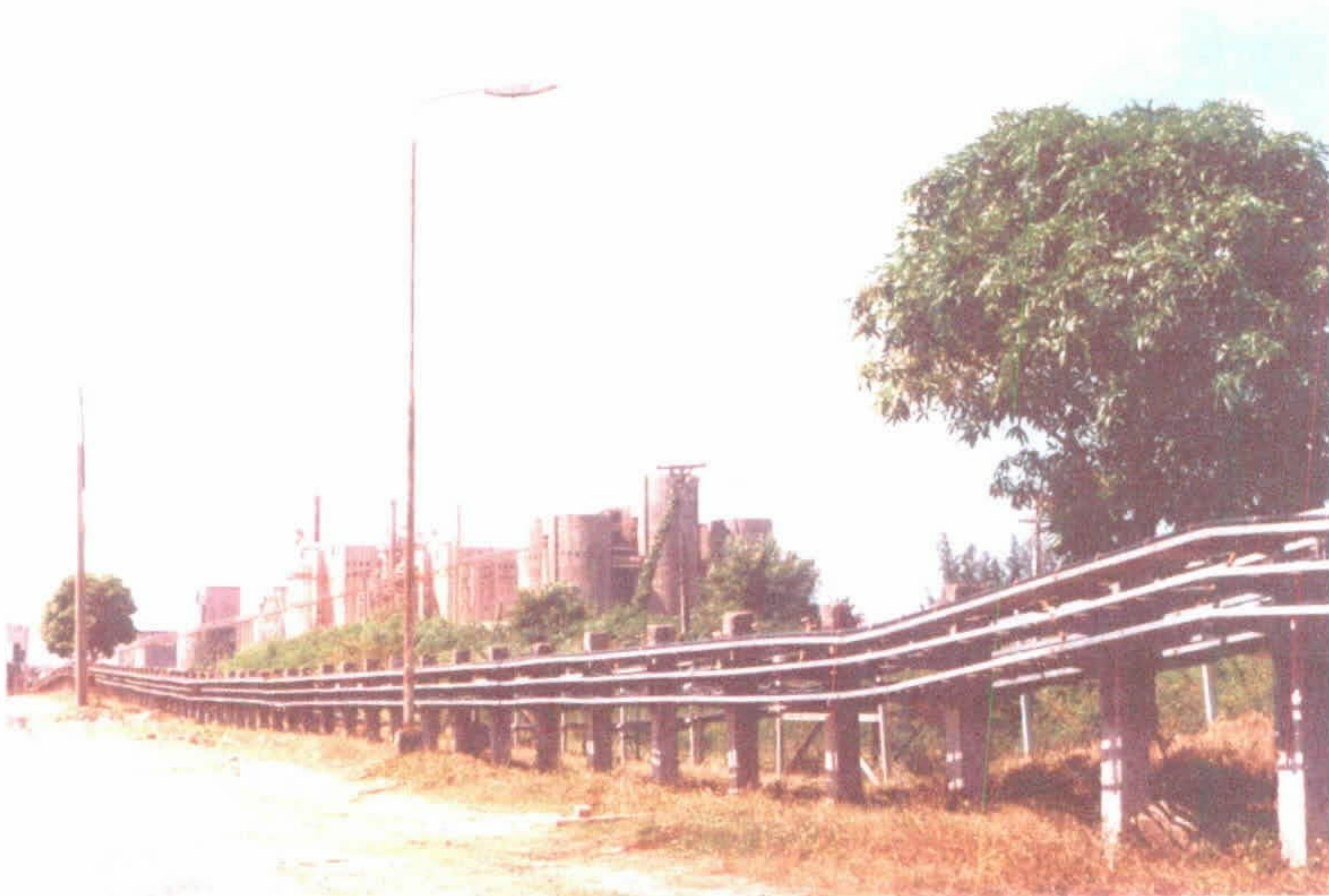
Foto 17 – Usina da empresa Cimentos Cienfuegos (Cienfuegos)
