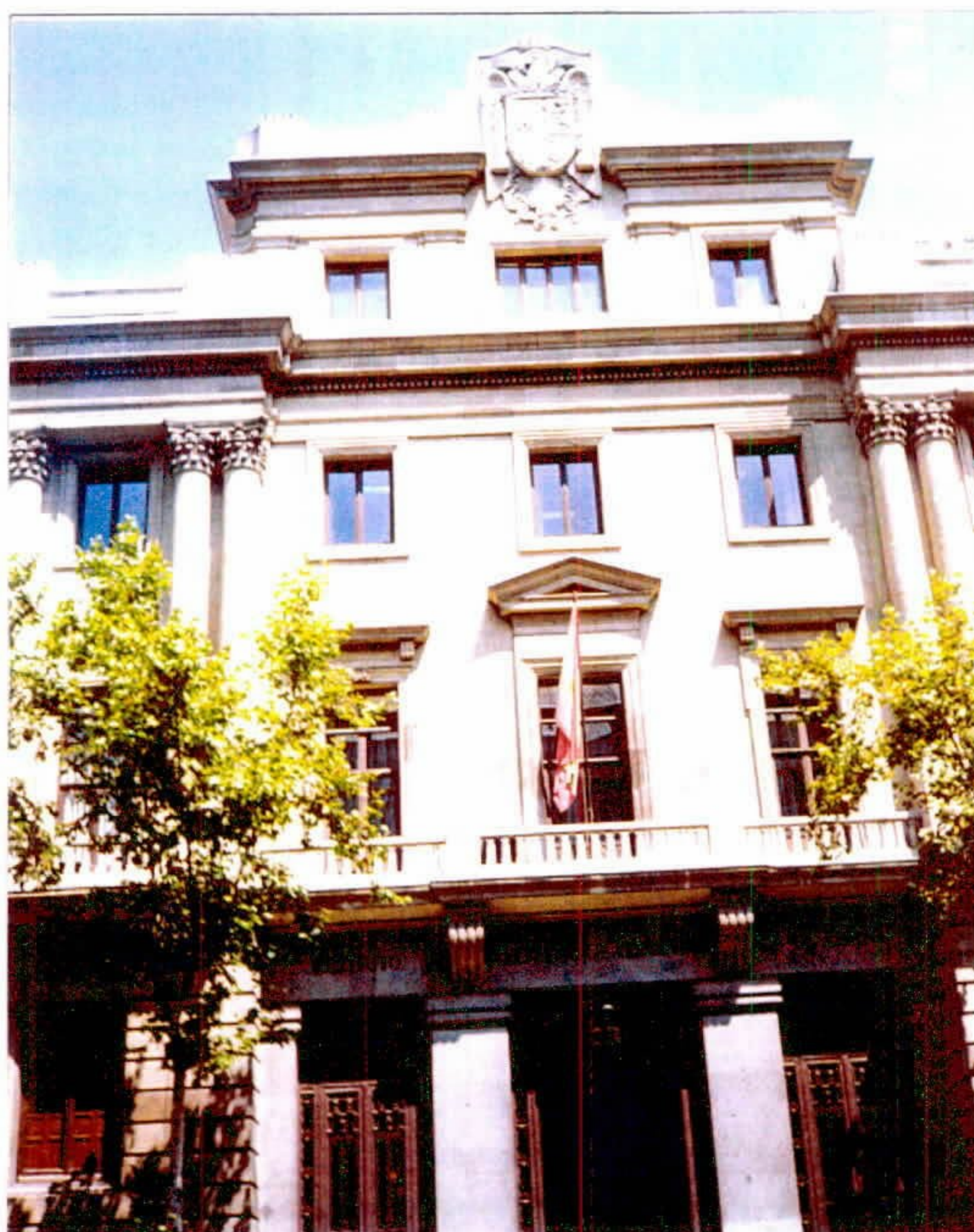
Foto 8 – Entrada do Edifício do ITGE
