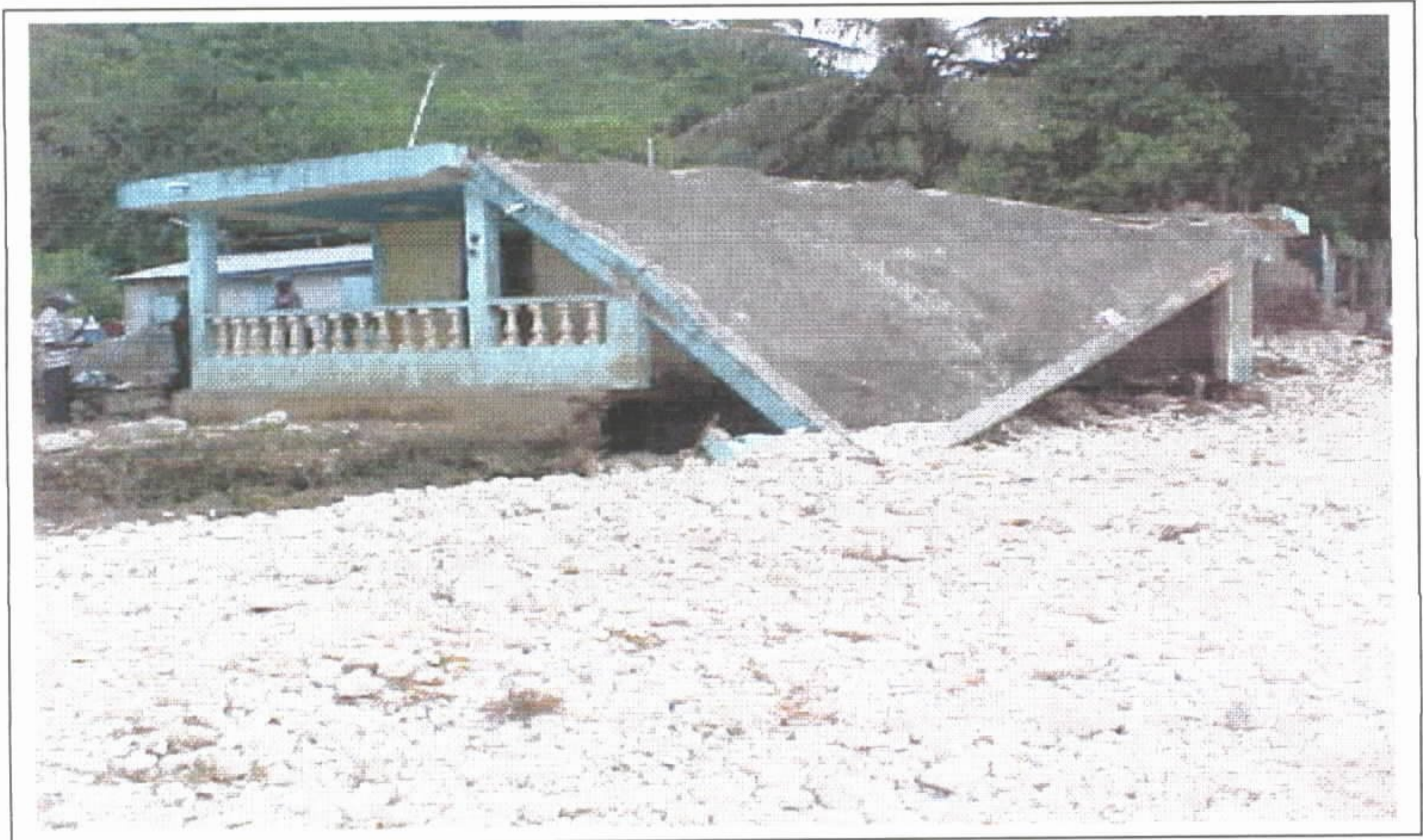
A quantidade de material de aluvião depositada no leito seco da ravina, demonstra a capacidade de transporte das águas durante a inundação
