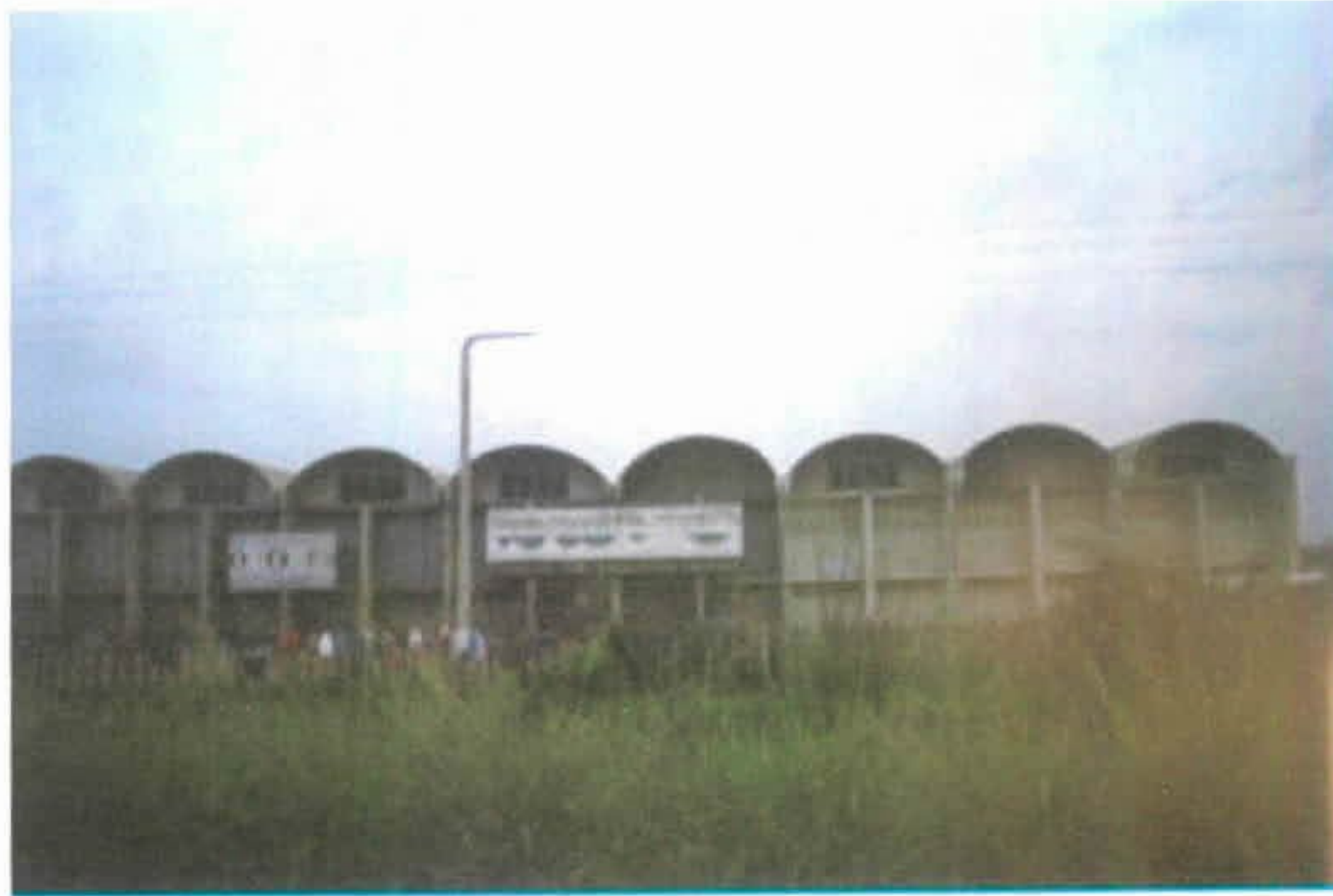
Figura 6 - Galpão de armazenamento e usina de beneficiamento de Pambros Salt
