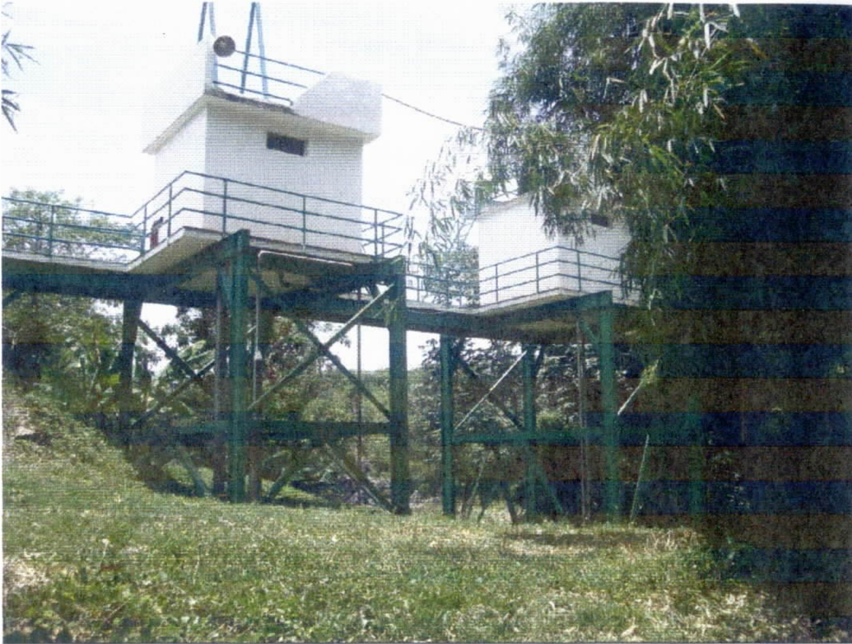
Poço reserva, para ser utilizado quando ocorrer qualquer problema com o poço principal, principalmente quando a área for inundada por efeito de furacões
