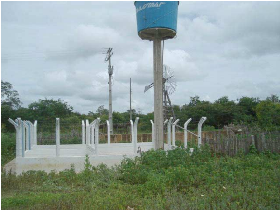
Foto 7.2 - Aspectos do SSA Sítio Mato Alto II concluído
